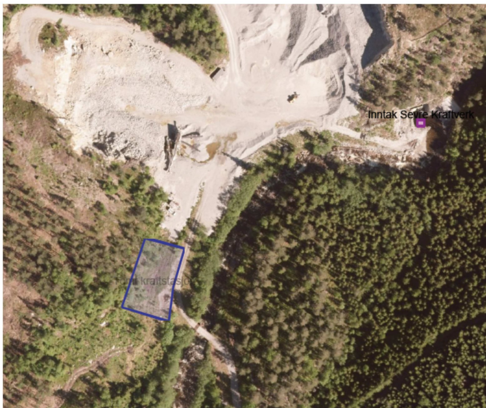
Oversiktsbilde som viser tomt for kraftstasjon. Øverst til høyre i bilde sees inntaket til Sevre Kraftverk.
