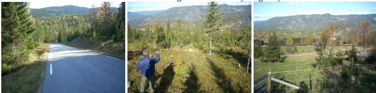
Bildene over viser øvre kryssningspunkt fylkesvei, samt del av rørtrase mellom de to veikryssningene.
