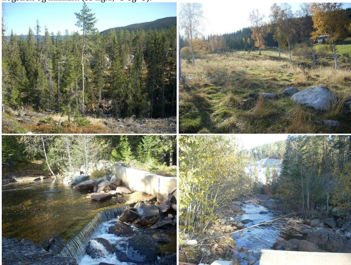
Figur 9: Øvre bilder viser hogstfelt nær elva og parti innmark i rørtraseen. Nedre bilder viser vanninntak ca kote 560 og steinbrudd nedstrøms planlagt kraftstasjon. Fotos: Ole Roer
