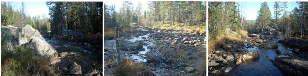
Bildene over viser inntakssted til venstre, areal neddemmet av inntaksdam i midten og elva få m nedstrøms dam .
