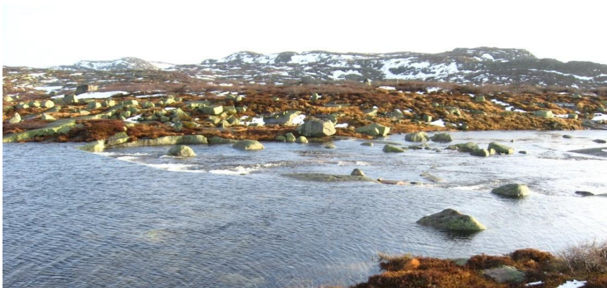
FIGUR 23: Sperredam ved Eivindsvatn med overløp.
