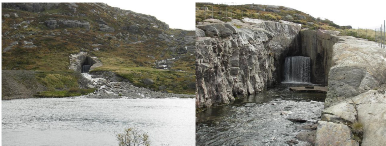
Bilde 2.2 (venstre) og 2.3 Inntaksområde (tilknytning til eksisterende tunnel)
