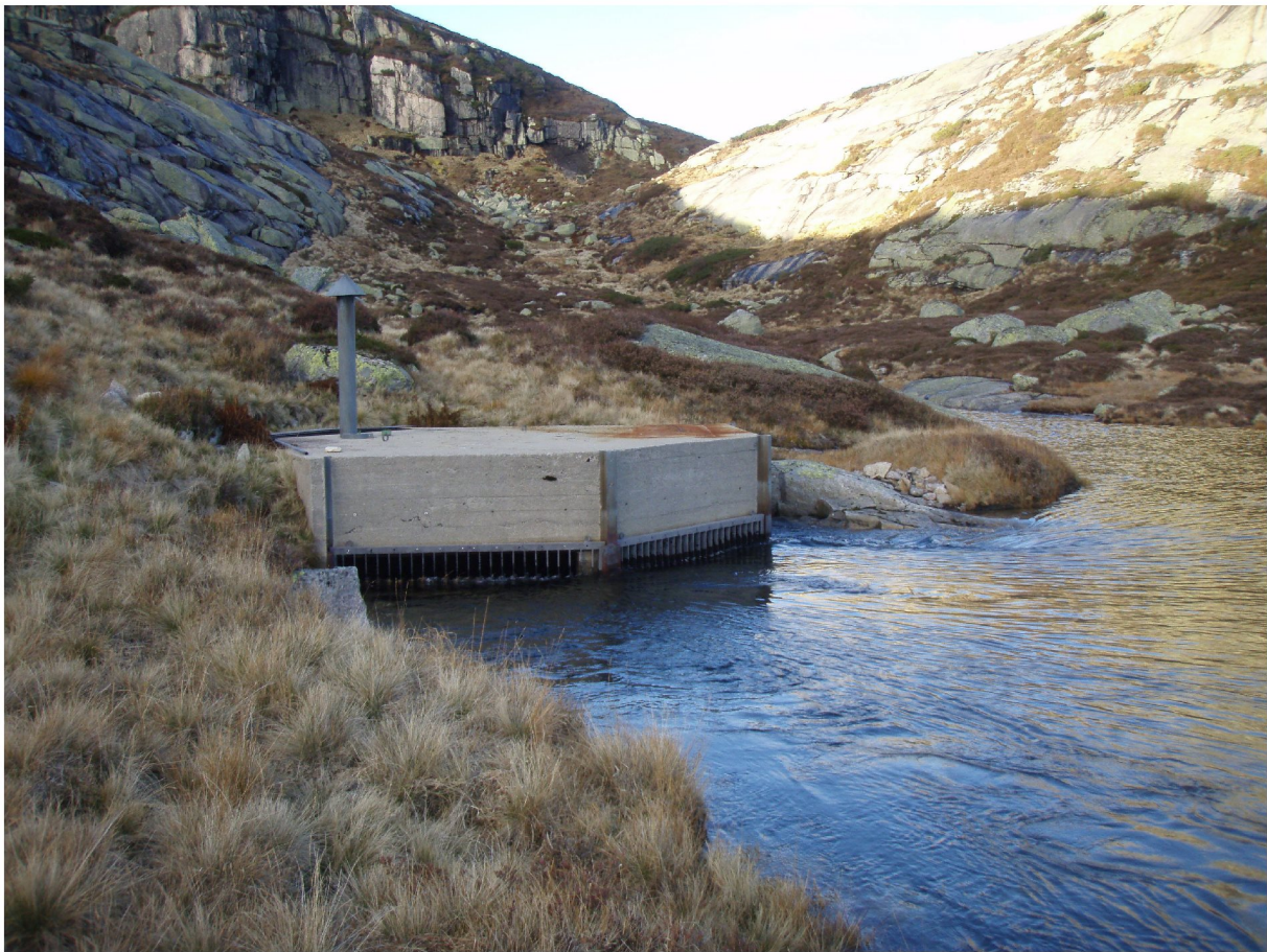
Tunnelinntak. Vannivå er her 55cm over bunnterskel, ca 10 cm under utløpsterskel mot Krokevatn.
