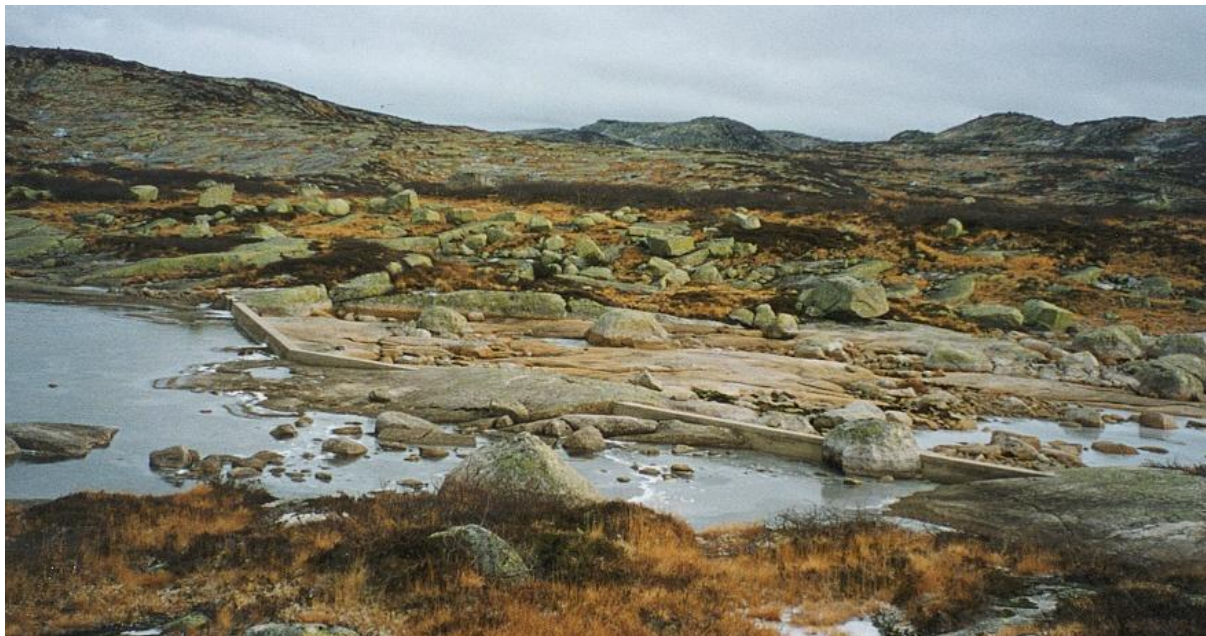
FIGUR 22: Sperredam ved Eivindsvatn uten overløp.
