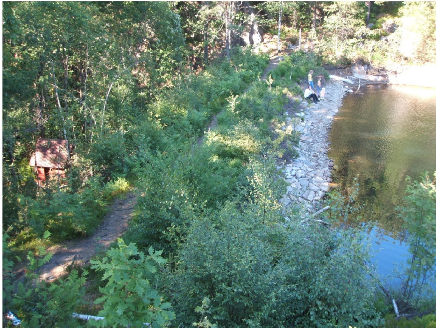
Oversiktsbilde av Vestre dam Brannvann
