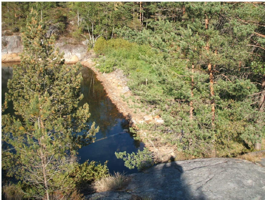
Oversiktsbilde av Østre dam Brannvann
