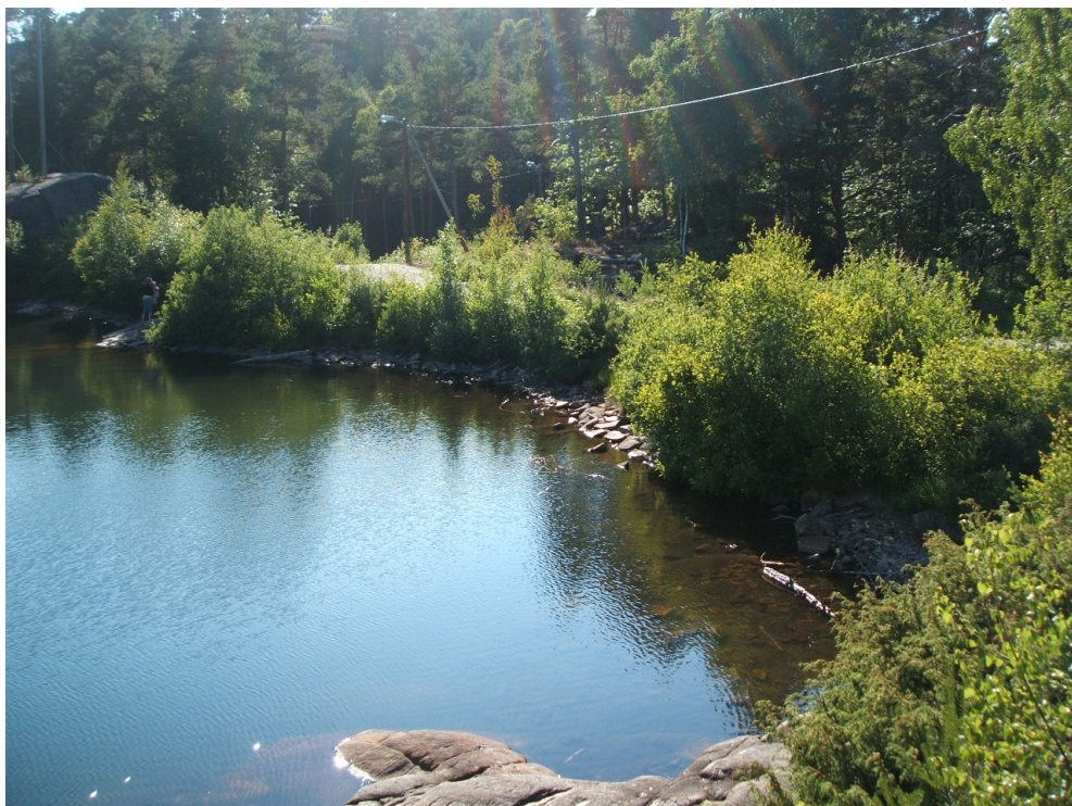
Oversiktsbilde dam Springvann, oppstrømsside
