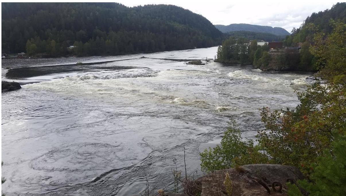
Figur 2-10 Ved flom er Firingsfossen begrensende for tappingen av Norsjø, og det blir strykpartier ned mot Skotfoss damanlegg.
