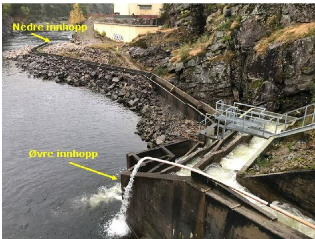
Figur 2-13 Fisketrappa sett fra dam, med nedre og øvre innhopp. Vannslipp fra rør er et forsøk på attraksjonsvann.
