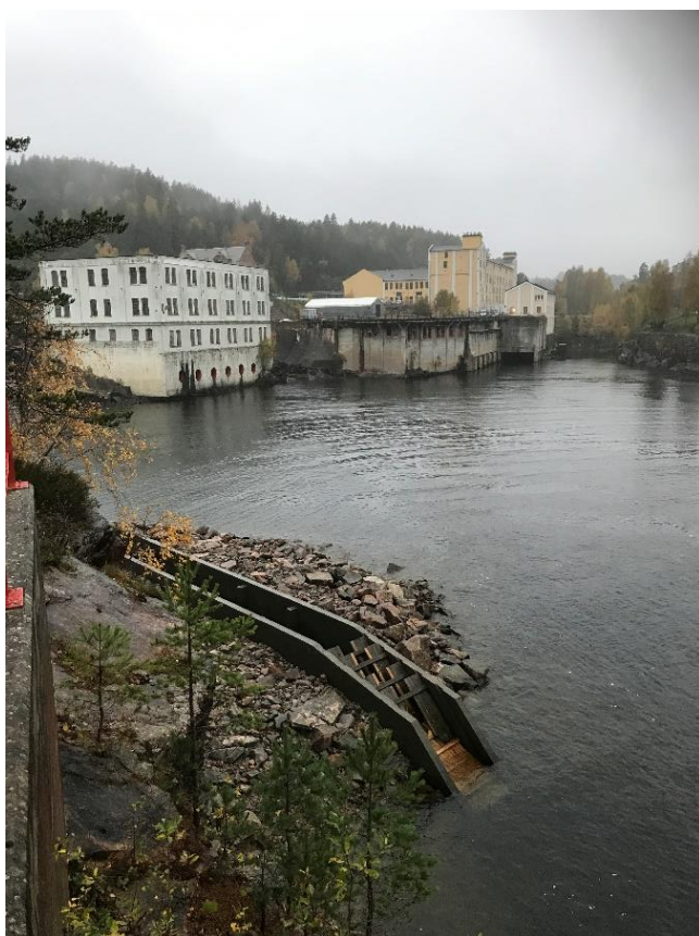
Figur 2-15 Nedre innhopp i fisketrappa med denilseksjon.
