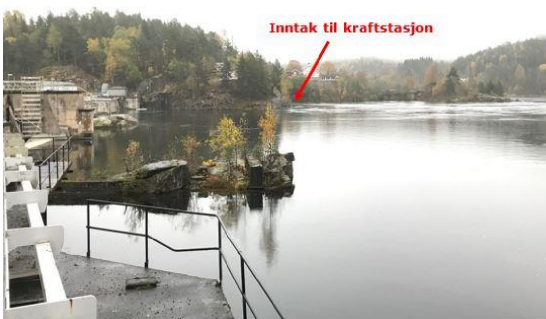
Figur 2-7 Damanlegget på Skotfoss sett mot sør. Inntaket til kraftstasjonen ligger ca. 150 m fra selve dammen.
