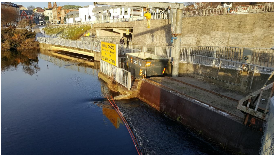
Figur 10: Turbininntakene til Eidet-kraftverkene. Foto: M. Kraabøl.
