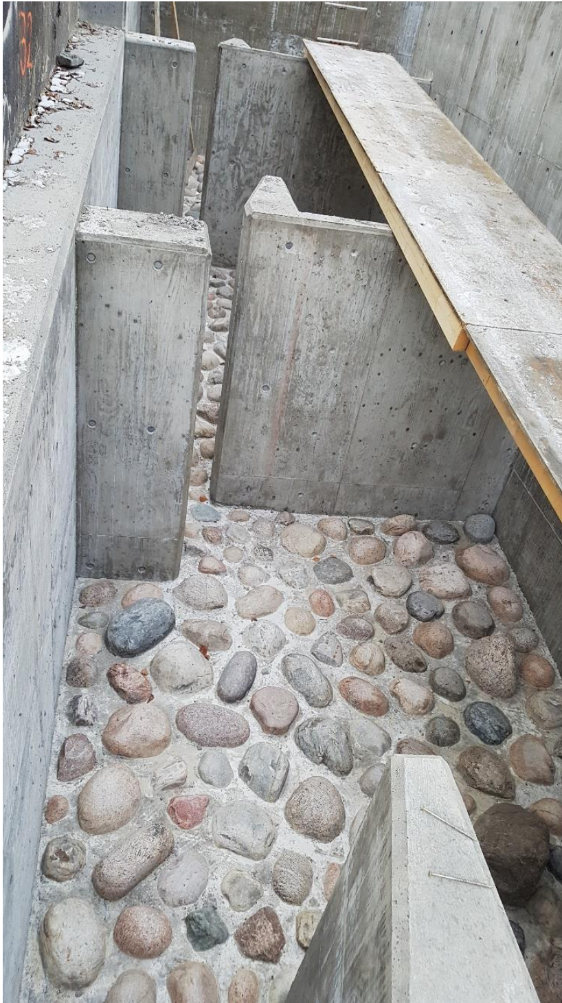
Figur 9: Innstøpt elvestein i bunnen av vertikalspaltet fisketrapp ved Møllefossen. Foto: M. Kraabøl.
