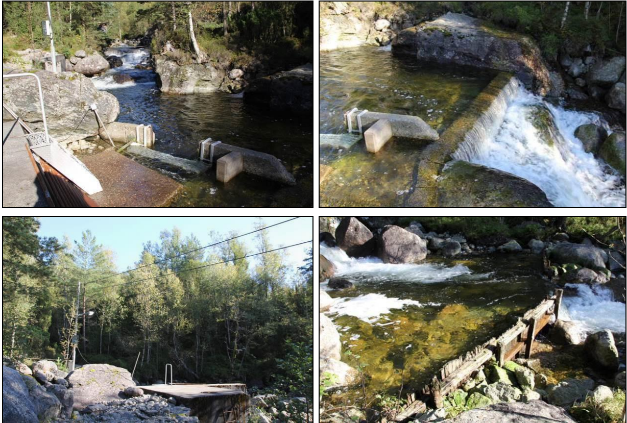
Figur 25. Inntaket til Husnes vannverk ligger like nedstrøms planlagt avløp fra Onarheimselva kraftverk (øverst og nederst til venstre). Damkonstruksjon med ukjent formål kote 130 (nederst til høyre).
