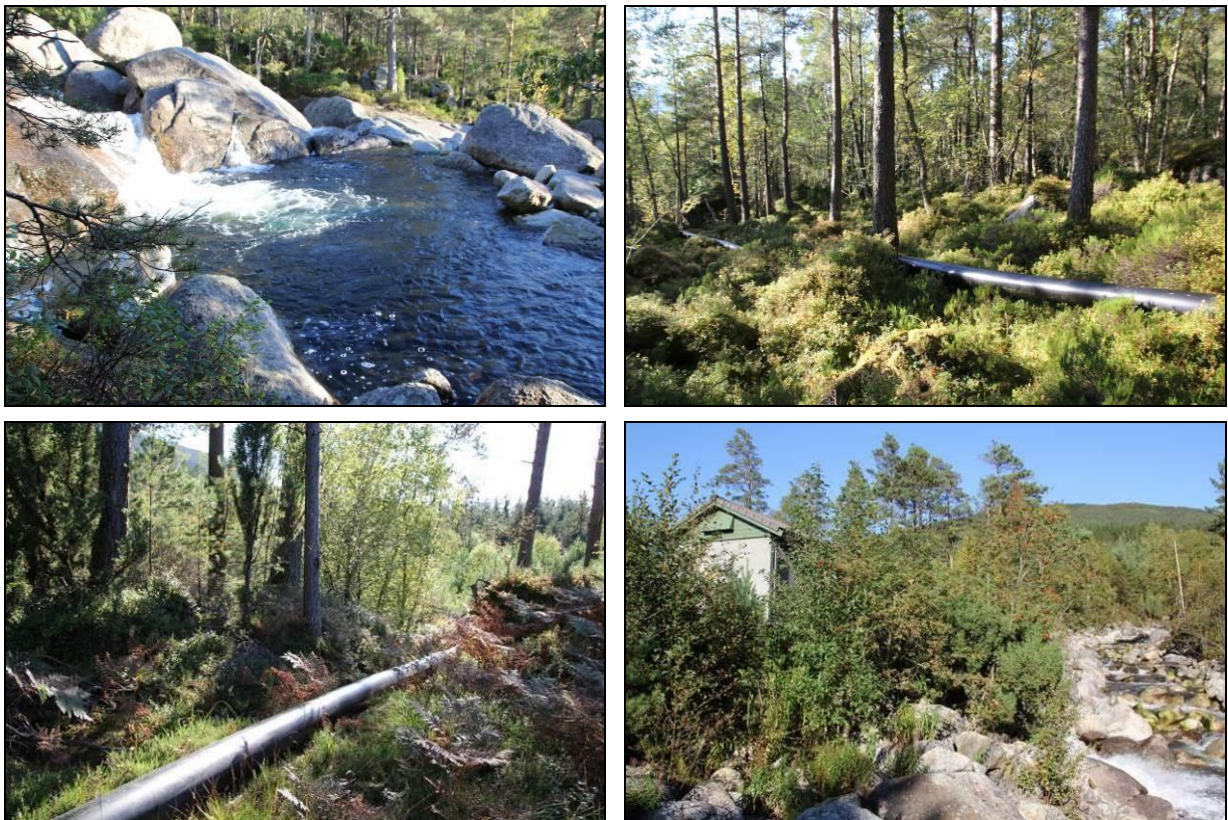
Figur 26. Madalen mikro kraftverk med inntaksdam, driftsvannvei og kraftstasjon med avløpskanal.
