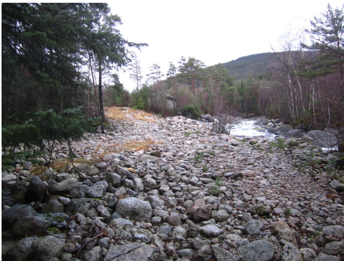
Figur 8 Kraftstasjonstomt sett fra vest. Bygget i bakgrunnen er Madalen mikrokraftverk.
