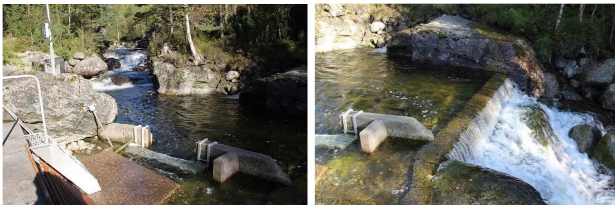
Figur 27 Inntaket til Husnes vannverk ligger like nedstrøms planlagt avløp fra Hellandselva kraftverk (foto: Rådgivende Biologer AS).
