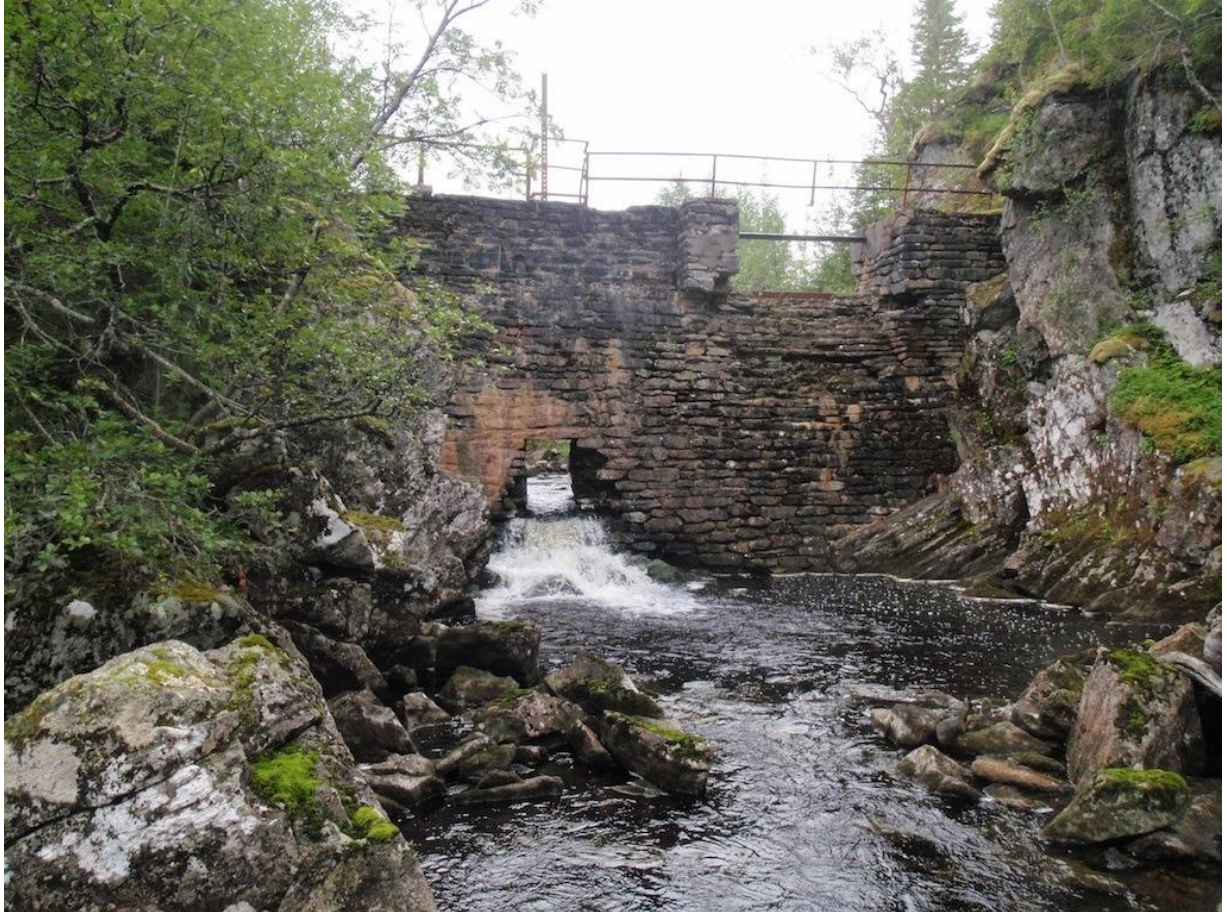
Figur 13. Her kan en se den ganske imponerende demningen nedenfor utløpet av Storårevatnet. Vi har fått opplyst at denne ble bygget for vel 100 år siden i forbindelse med etablering av et kraftverk nede ved sjøen. (Foto; Bioreg AS ©)
