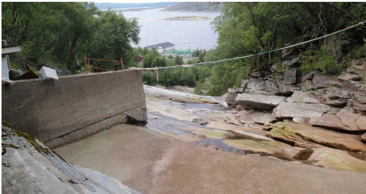
Figur 20. Bildet er tatt fra vassinntaket til settefiskanlegget som kan skimtes nede ved sjøen. Herifra går elva i fosser og stryk helt ned til stasjonsområdet. (Foto; Bioreg AS ©).
