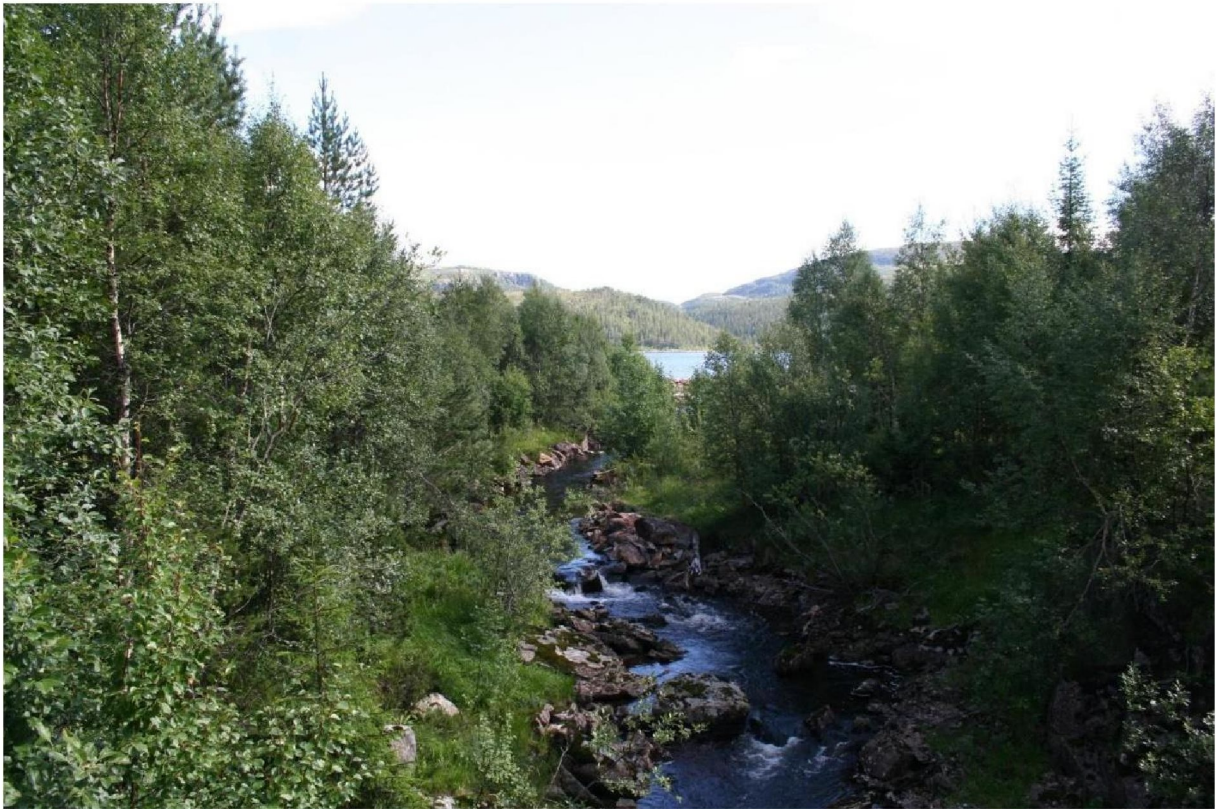
BILDE 4: KANALEN MELLOM STORÅREVATNET OG DAMMEN. BILDET ER TATT FRA TOPPEN AV DAMMEN. VANNFØRINGEN PÅ BILDET ER BEREGNET TIL 0,12 m 3 /s.
