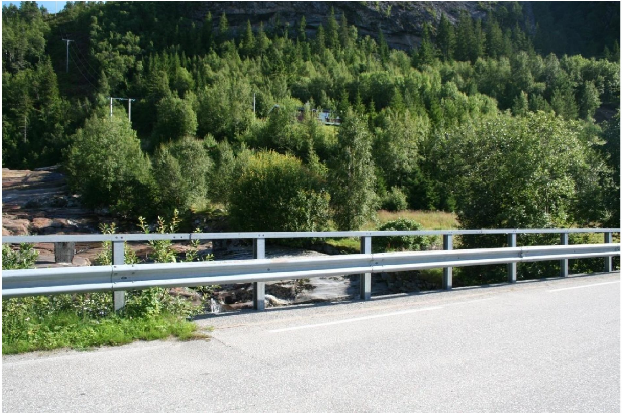
BILDE 39: STASJONEN BLIR PÅ SLETTEN MIDT I BILDET. RØRGATEN KOMMER NED GJENNOM SKOGEN TIL VENSTRE. BILDET ER TATT FRA FV. 718 VED FESSDALELVAS UTLØP I STJØRNEFJORDEN.
