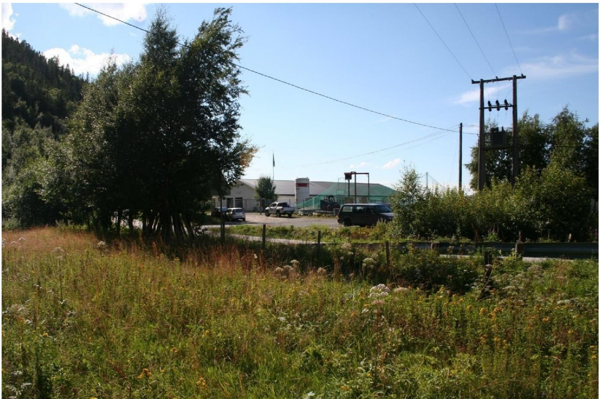
BILDE 40: SMOLTANLEGGET SETT FRA STASJONSOMRÅDET, MED FV. 718 I MELLOM.
