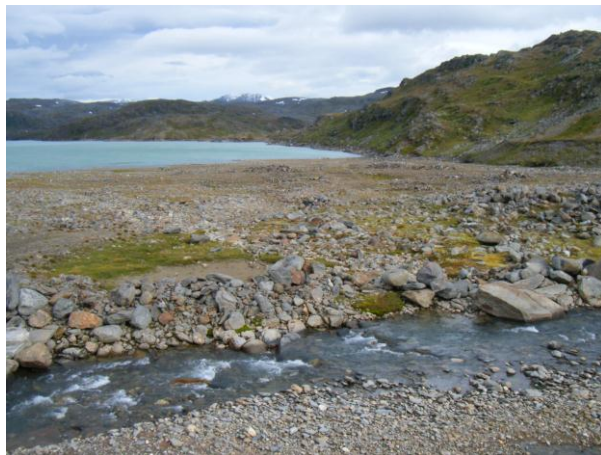
Anleggsvei/kabel fra stasjon over grusvifte
