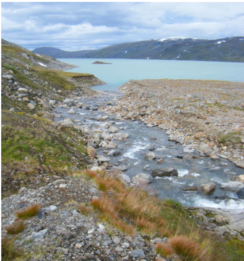
Figur 12 – Kraftstasjonsplassering - på fjell, ca. kote 679 (HRV Siso er 671). Området på vestsiden – der stasjonen skal bygges er preget av tidligere uttak av morene-/grusmasser til eksisterende dammer. Som det går fram på bilde, flater terrenget ut nedenfor planlagt kraftstasjonsplassering.
