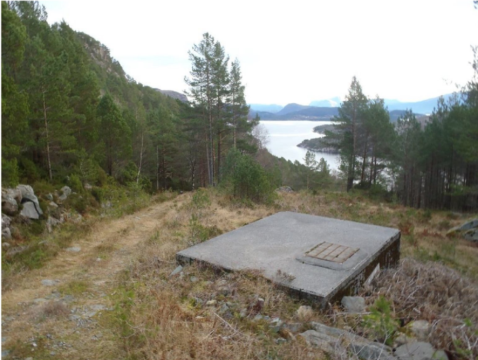
Parti nedanfor trykkreduksjonsanlegg. Viser anleggsveg som vart bygd i samband med siste utbygging av vassverket i 1995. Røyrgatetrasè vil ligge til venstre for vegen.
