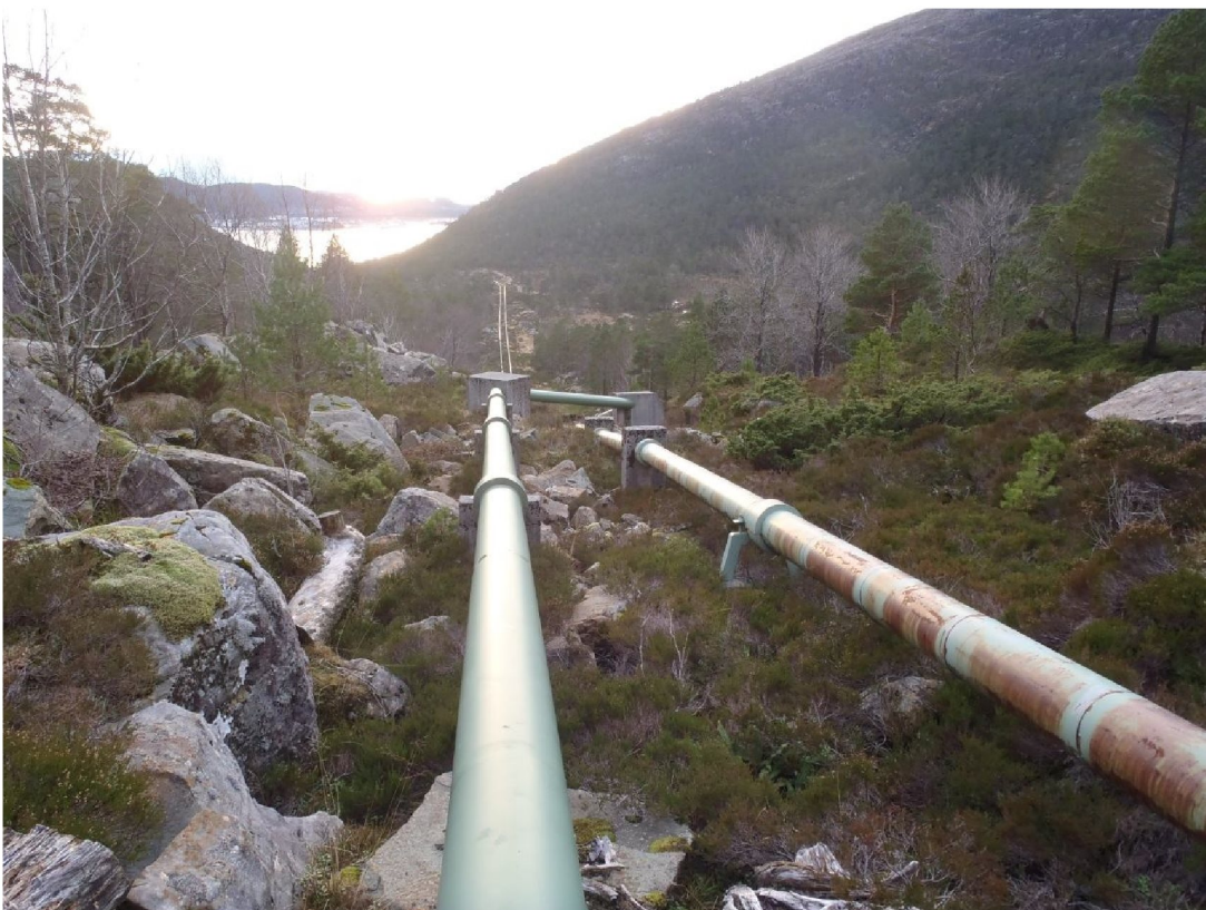
Overføringsleidningar Florø vassverk.
