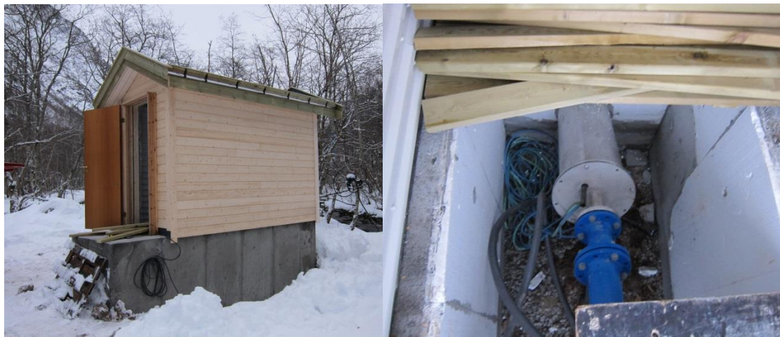
Figur 6 Brønnhus for brønn 1. Bildet til høyre viser brønntoppen under brønnhuset.
