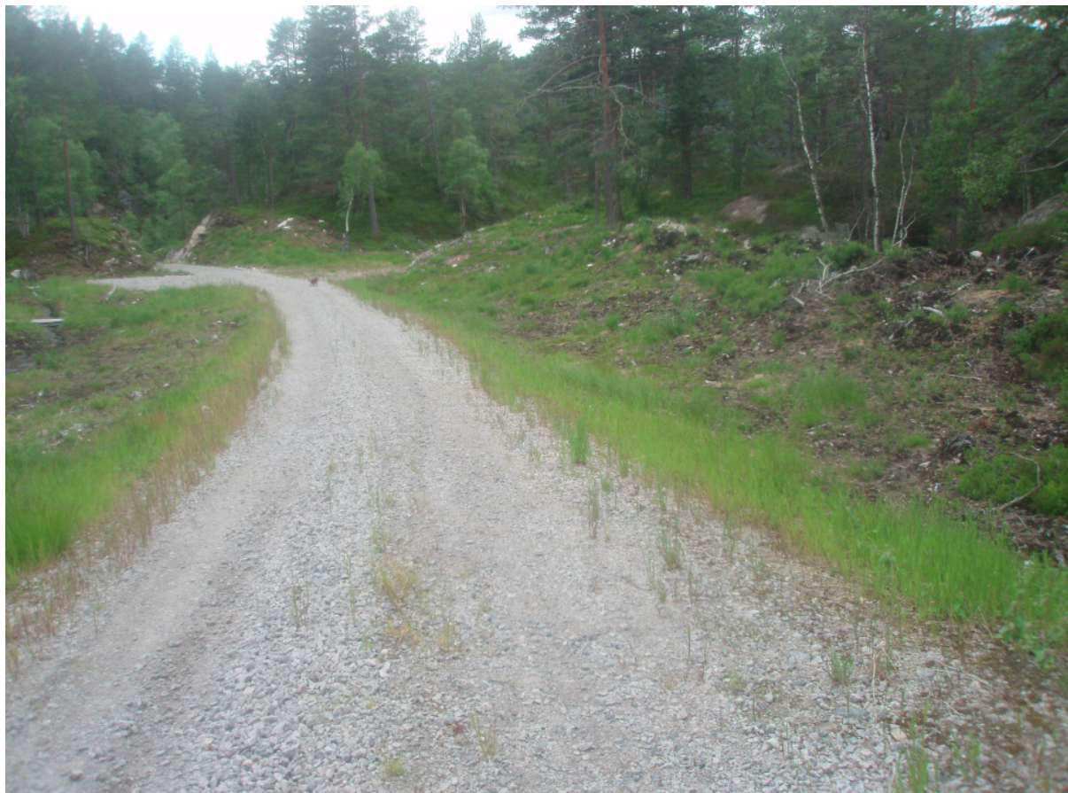
Figur 8Bilde av vei som ble bygd
