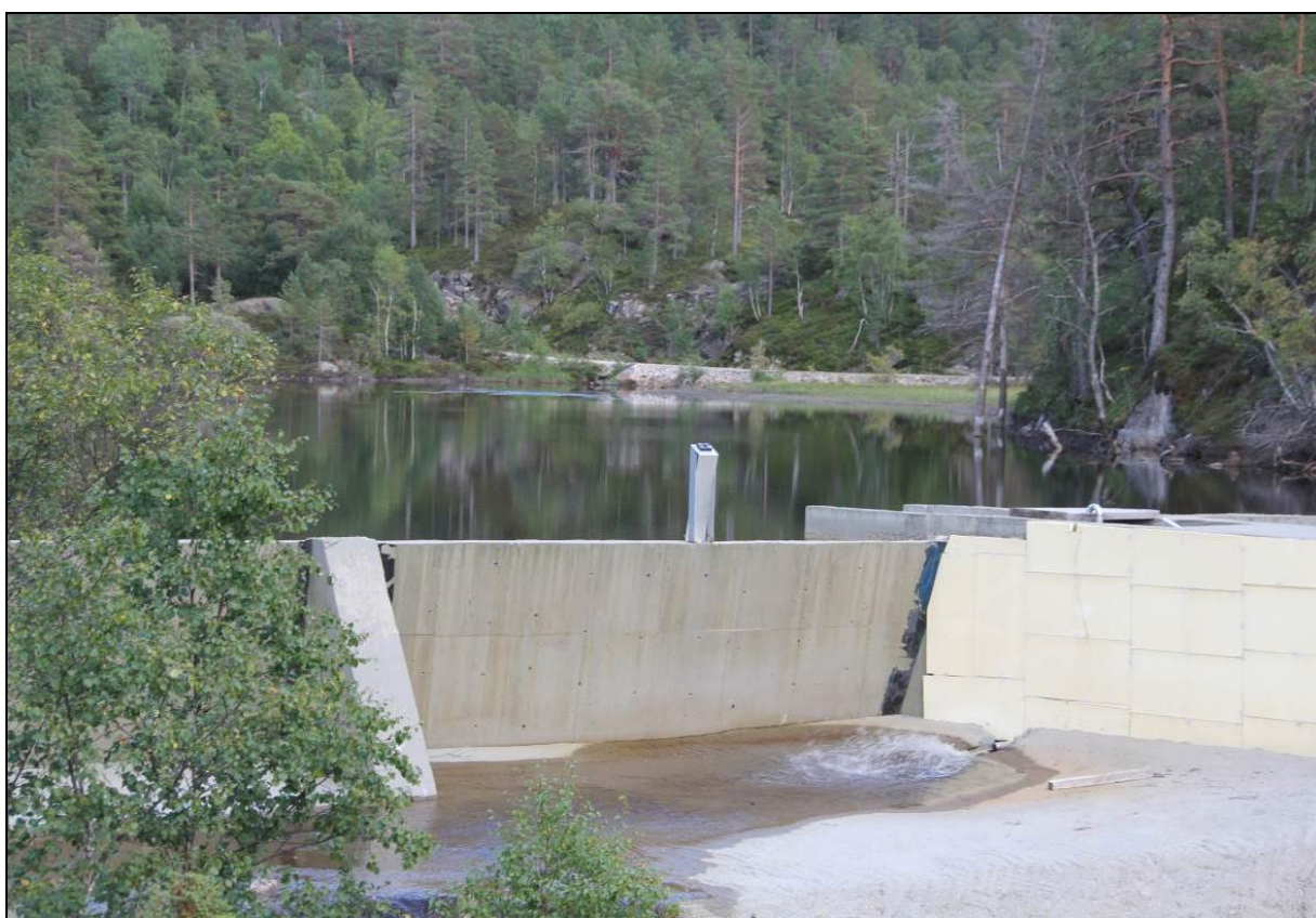
Figur 1. Inntaksmagasinet for Veiåni kraftverk 30. august 2013. Foto: Ole Kristian Spikkeland.
