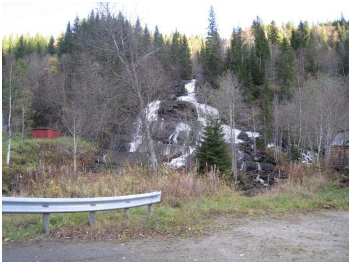
Figur 11: Bilde tatt fra østsiden av bru (E14) over Meåa like ved planlagt kraftstasjon (E14) 28.10.2010. Q = 0,84 \text{ m}^3/\text{s} .
