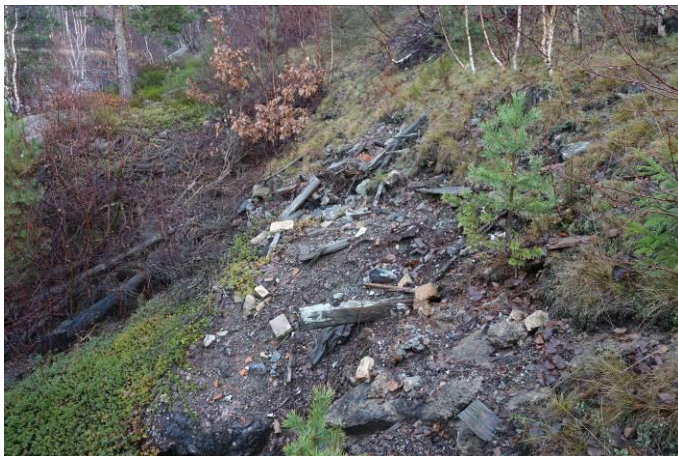
Figur 3. Noe av innholdet i fyllinga under trafoanlegget
