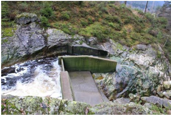
Fig 3.7.1. Inntaksdam og vandringshinder for Smeland Kraftverk (Agder Energi AS) på kote 375 1,8km nedenfor tiltenkt kraftstasjon.
