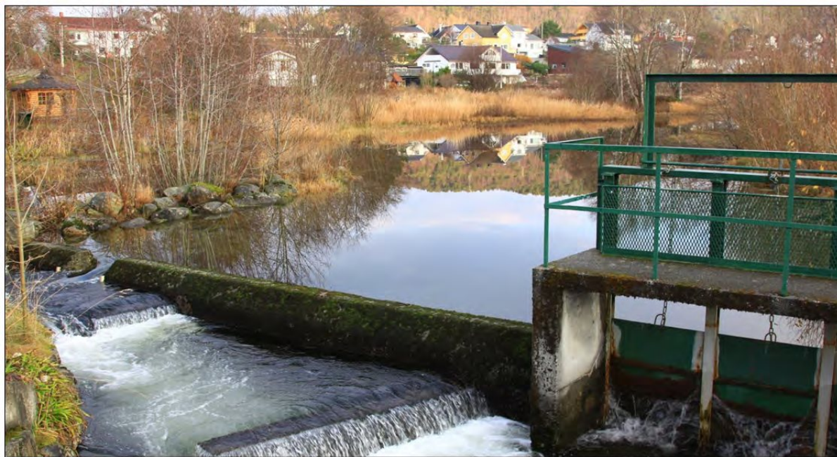
Figur 3. Demningen ved utløpet av Lillevatnet.
