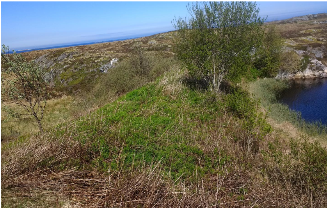
Figur 11: Bilde av fyllingsdam ved det opprinnelige utløpet fra Kolbergtjønna.
