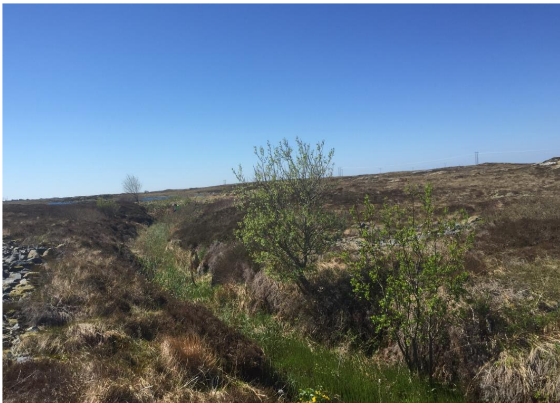
Figur 12: Bilde av overføringsgrøft fra Kolbergvatnet (jfr. oversiktskartet på figur 5).
