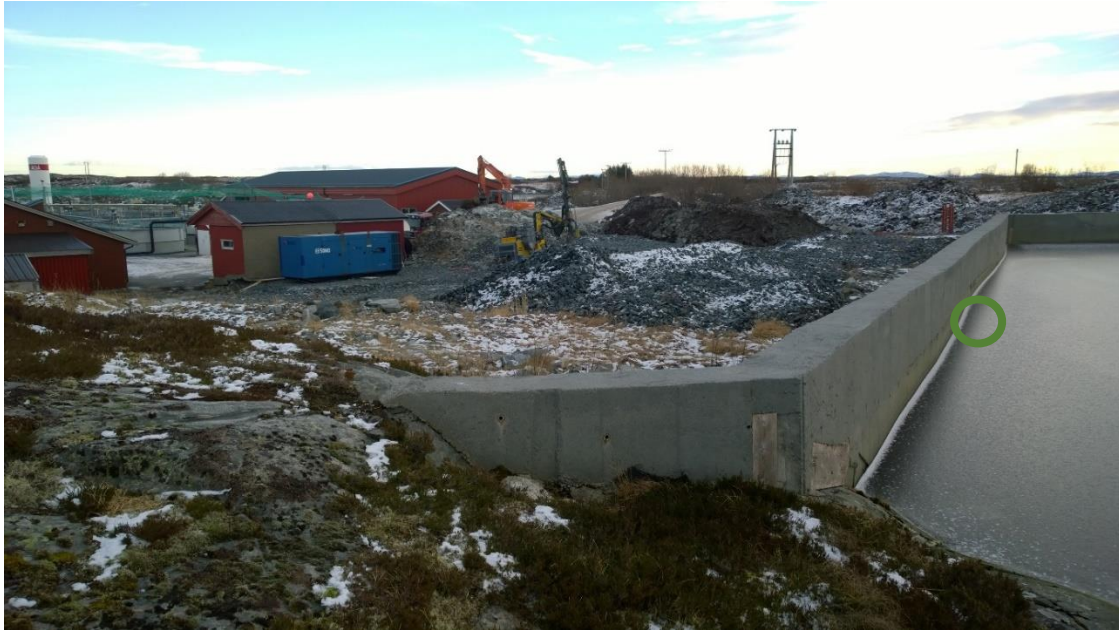
Figur 10: Bilde av dam mellom Fløvatnet og Smøla Klekkeri og settefiskanlegg. Vanninntak merket med grønn sirkel.
