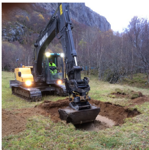
Figur 5 Graving ved Bh2 som viser sandige masser ved overflaten, Sumstad vannverk
