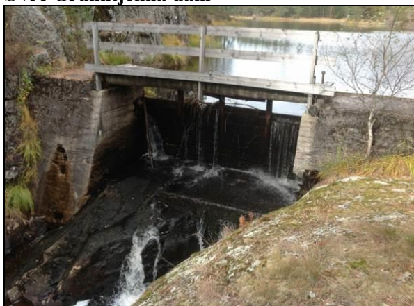
Øvre Grunntjenna dam
