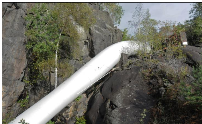
Figur 7. Den «nye» vannveien fra 1990
