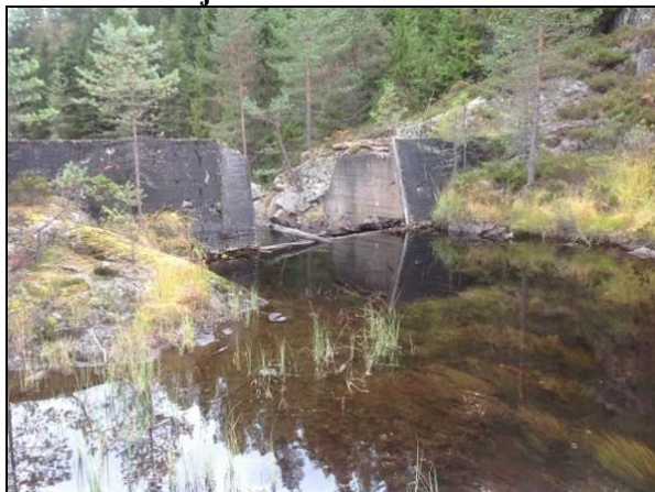
Nedre Grunntjenna dam
