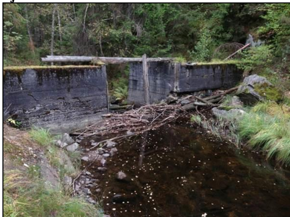
Fjølbu vannet dam
