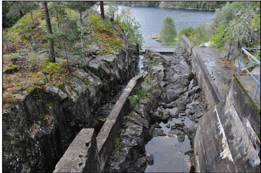
Figur 11. Utløp fra Grummestadvatnet er todelt, sett fra dammen.
