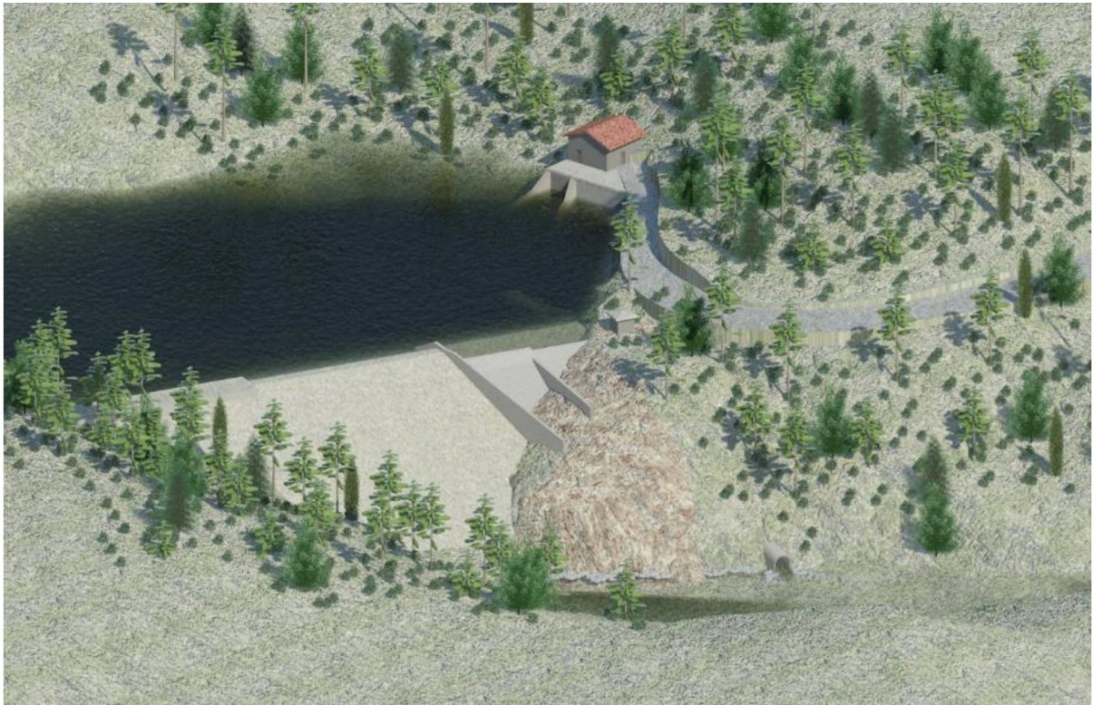
Figur 6 Inntaksdam og inntak ved Merravadet
