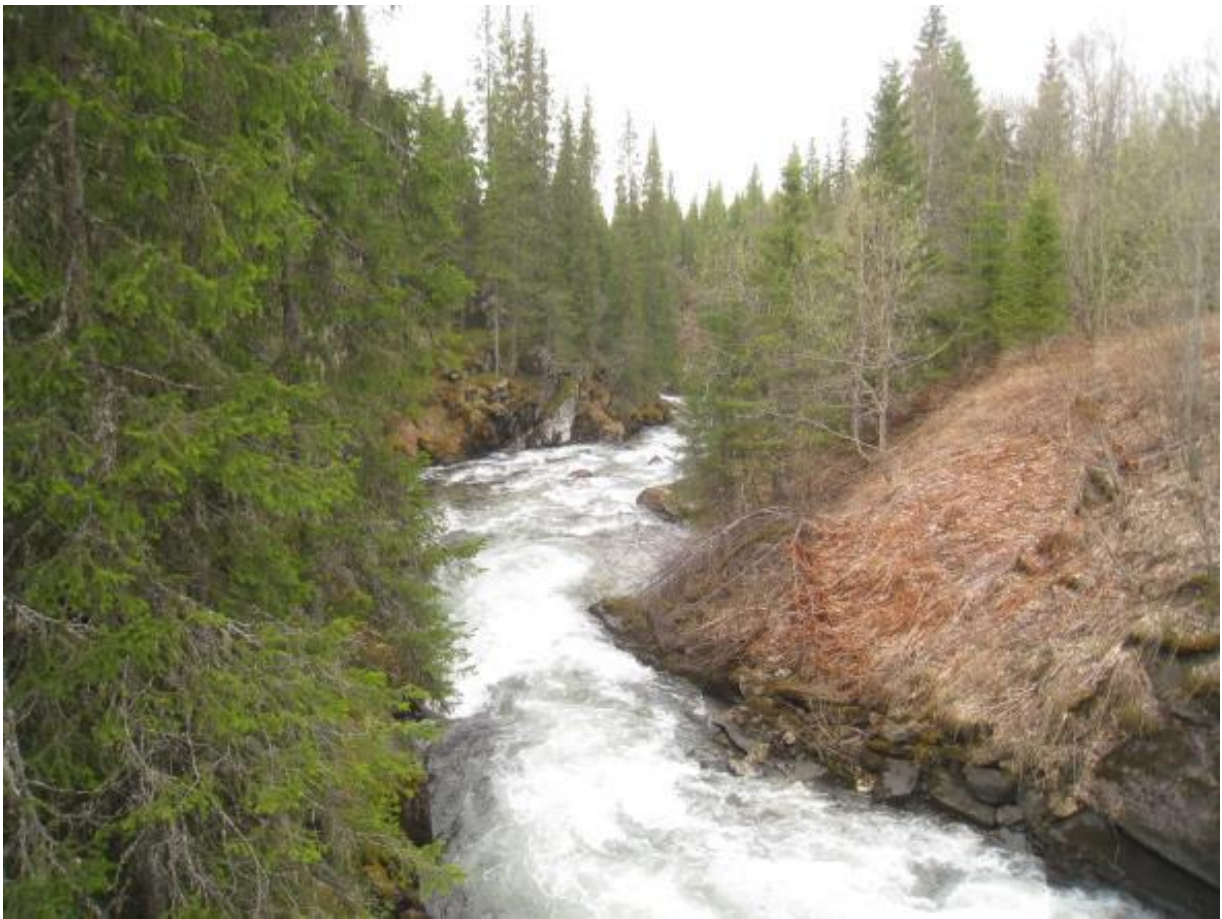
Silåga nedstrøms veibru. Damsted og bekkeinntak til venstre ved fjellkant.
