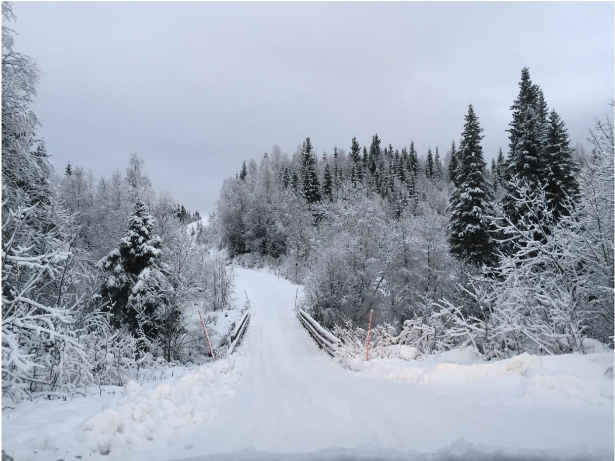
Stupformoveien bru. Kabeltrase langs vei
