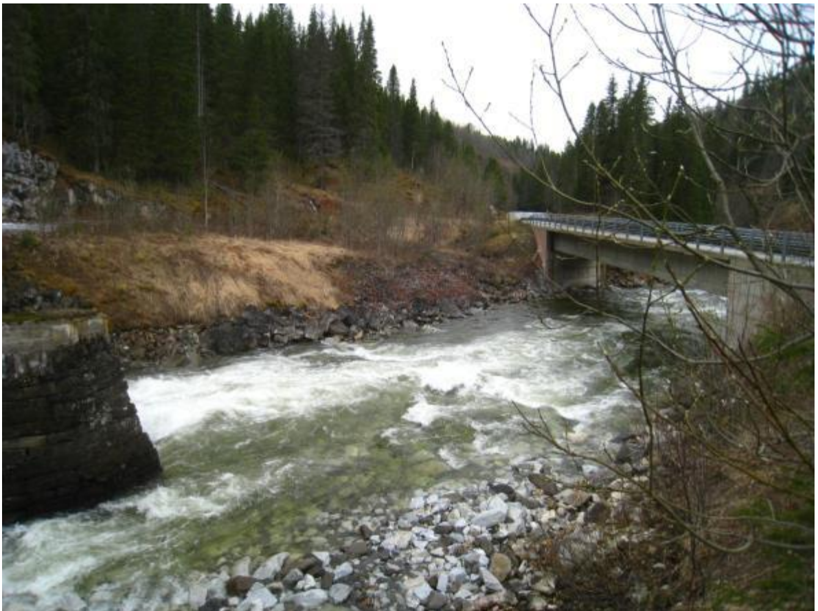
Fv. 357 bru over Grønfjellåga. Gammelt brufundament tv.
