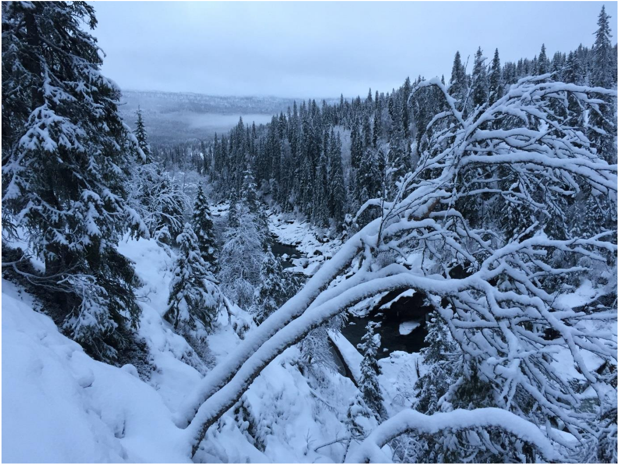
Kryssing Ranelva i luftspenn.
