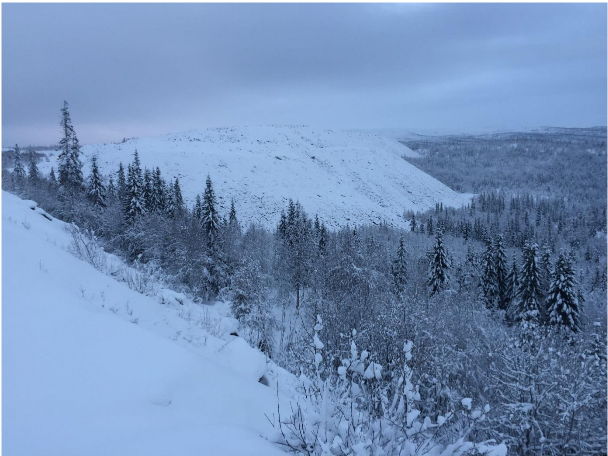
Steintipper ved Ørtfjell trafostasjon
