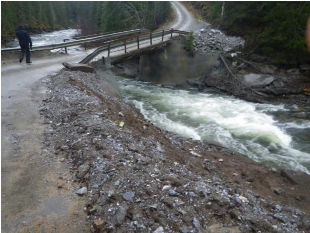
Vei til Rabben. Adkomst til Rabben, dam og inntak over bru over Grønfjellåga.
