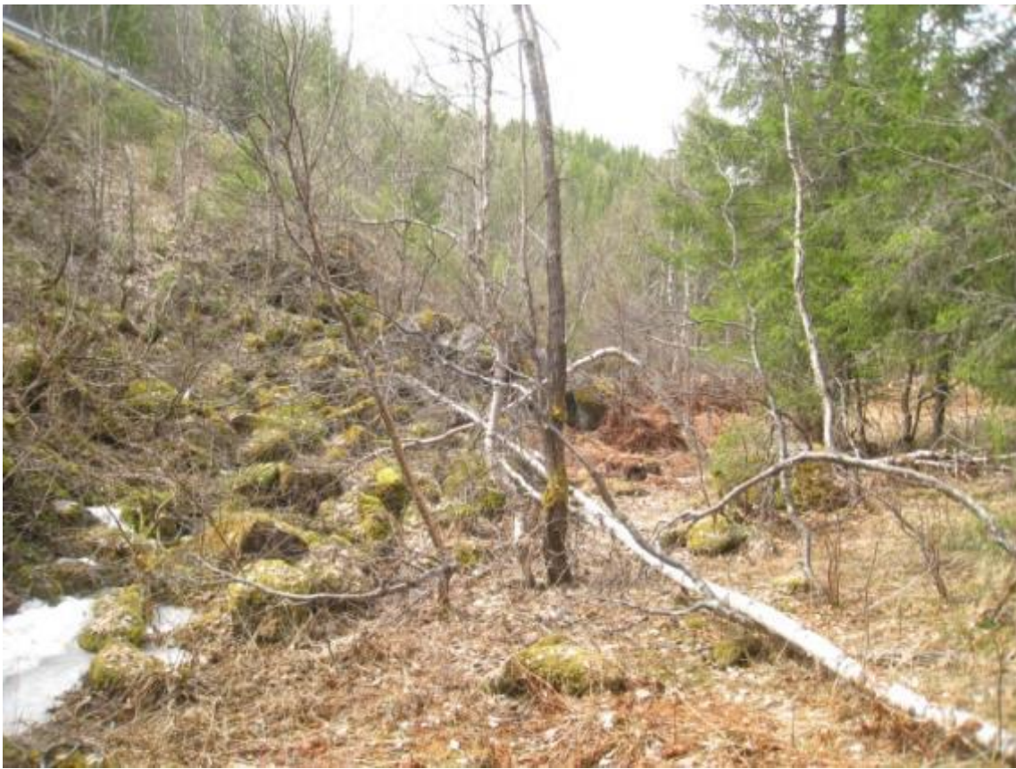
Tunnel / rørkulvert anlegges under vei
