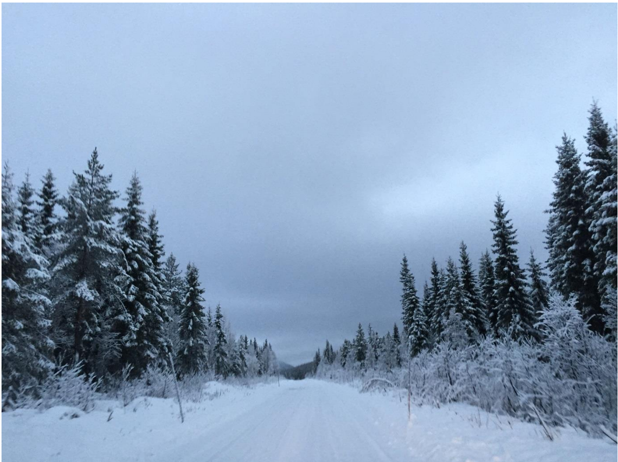
Stupforsmoveien. Kabeltrase til side for vei
