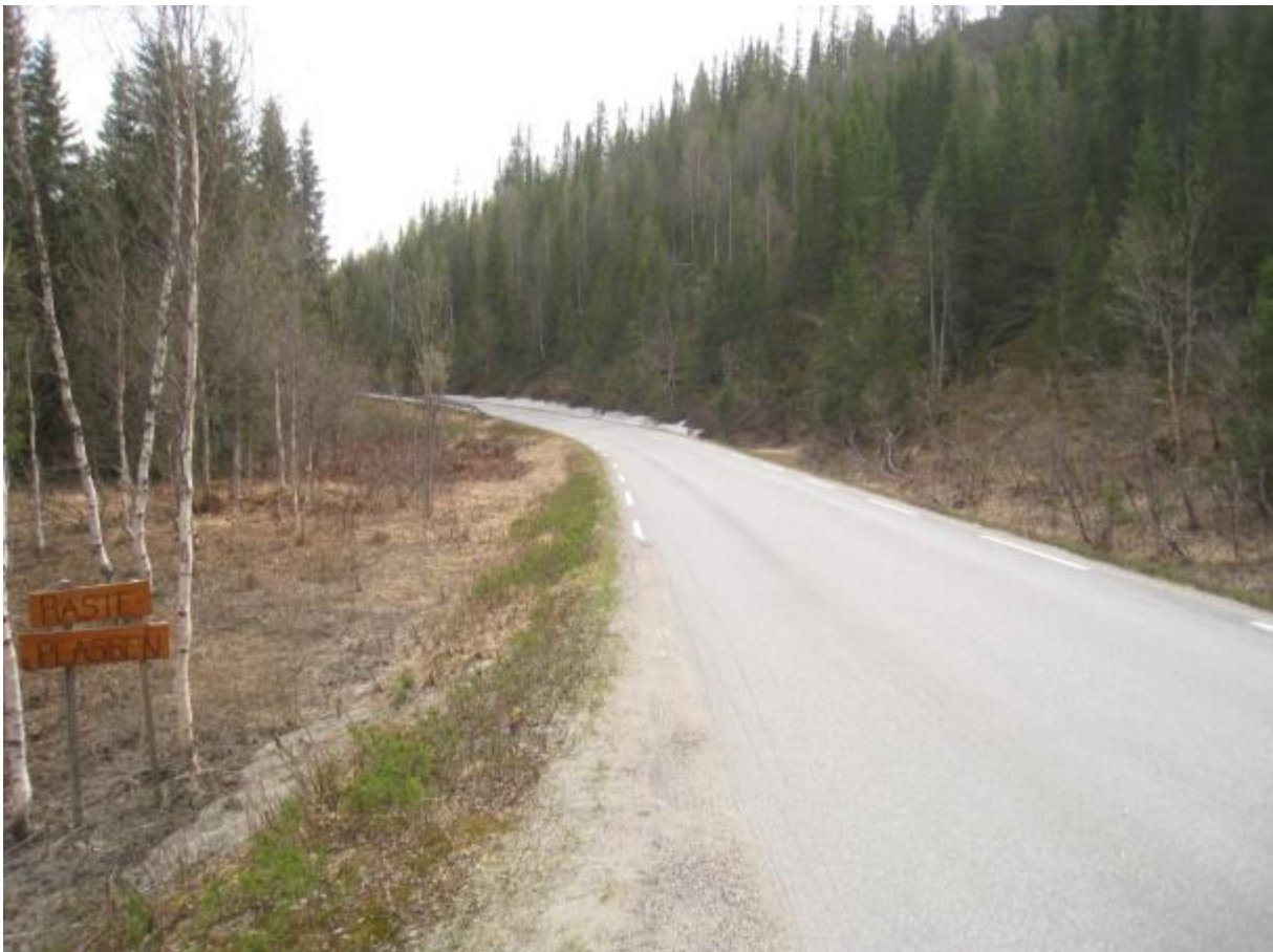
Område for avkjøring til kraftstasjon ved rasteplassen ved Austervollen.
