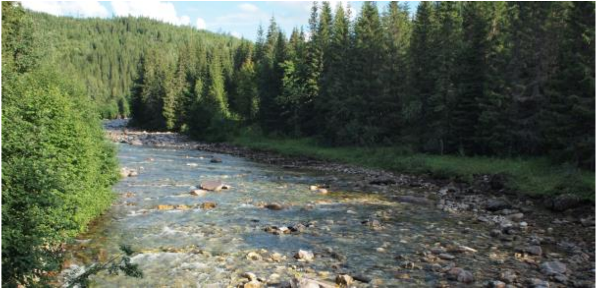
Utløpskanal fra kraftstasjonen munner ut midt i bildet.
