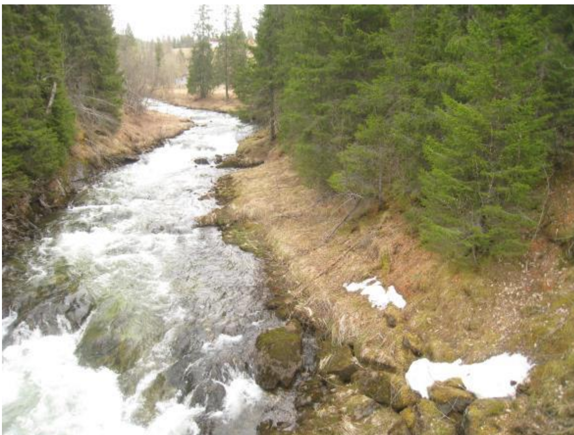
Silåga oppstrøms veibru og overføring.
