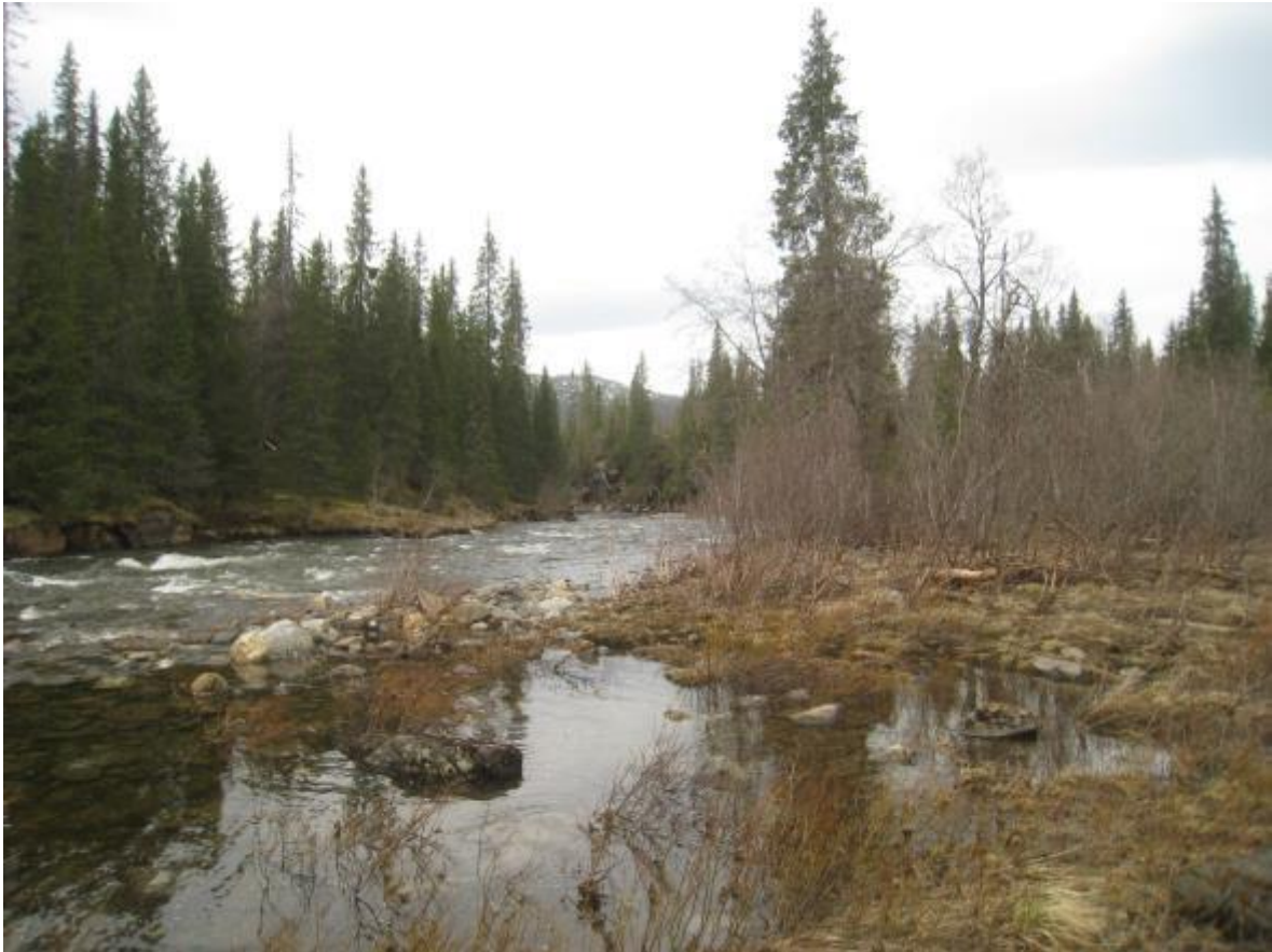
Poshølen. Øvre ende av inntaksbasseng.
