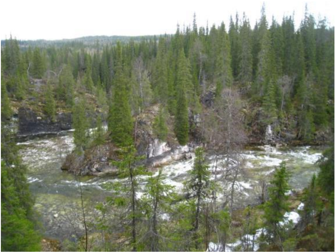
Inntaksområde, sett mot damsted (bak utstikkende fjellrabb). Inntak tv. i fjellvegg.
