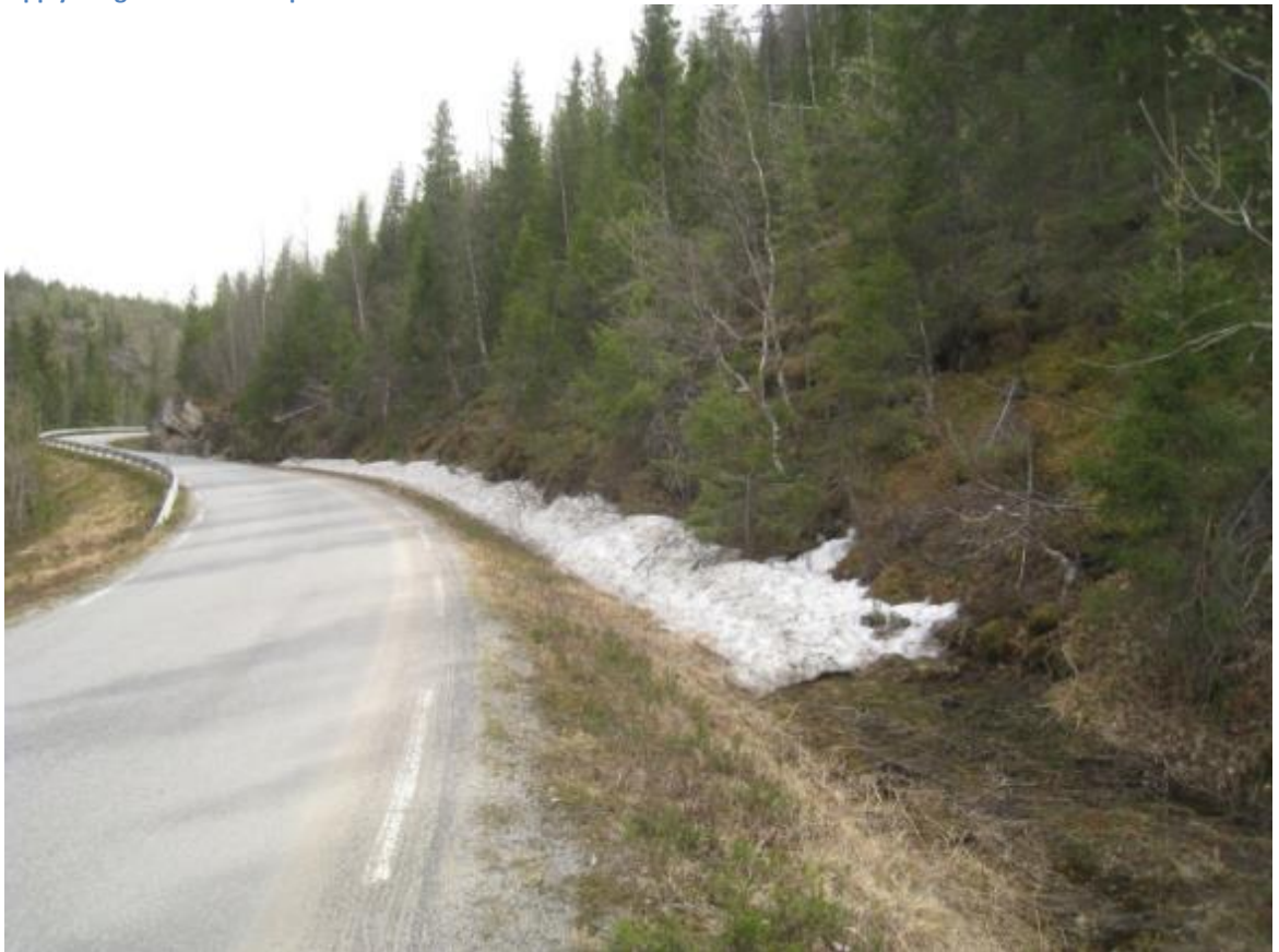
Fv. 357. Kraftstasjonsområde tv. nedenfor veien.
