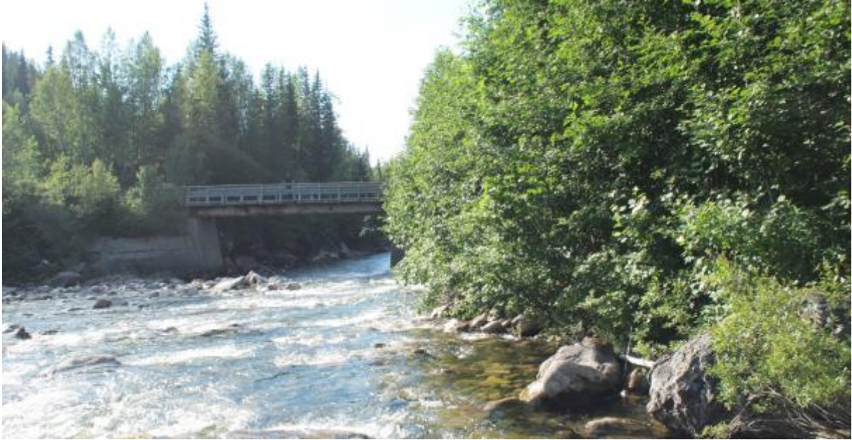
Stupforsmobrua. Nedstrøms utløpskanal.
