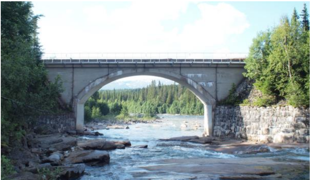
Jernbanebru på Nordlandsbanen ved samløp med Ranaelva.
