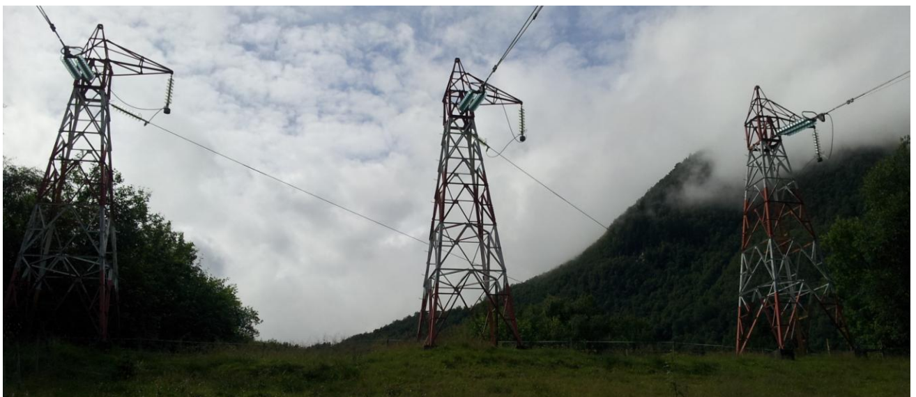
Figur 10. Eksempel på 132 kV fjordspennmaster.
