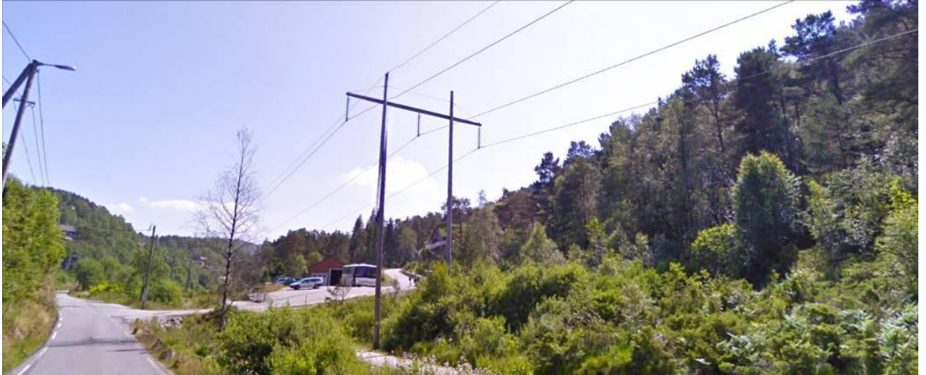
Figur 8. Eksempel på 132 kV kraftledning bygget på H – master av trestolper med toppline.
