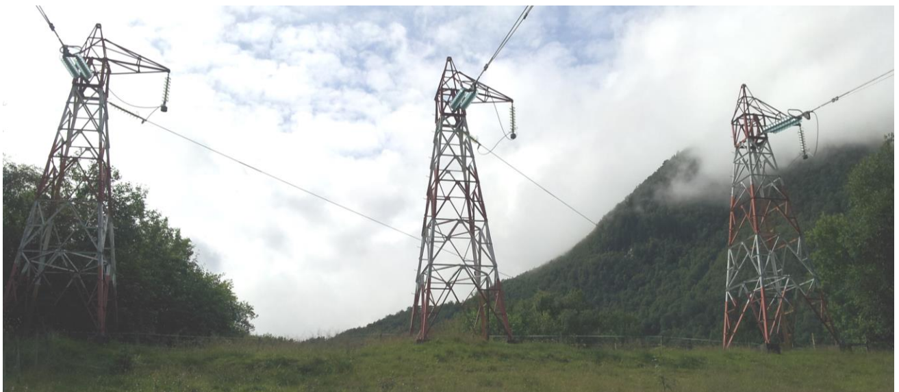
Figur 10. Eksempel på 132 kV fjordspennmaster.
