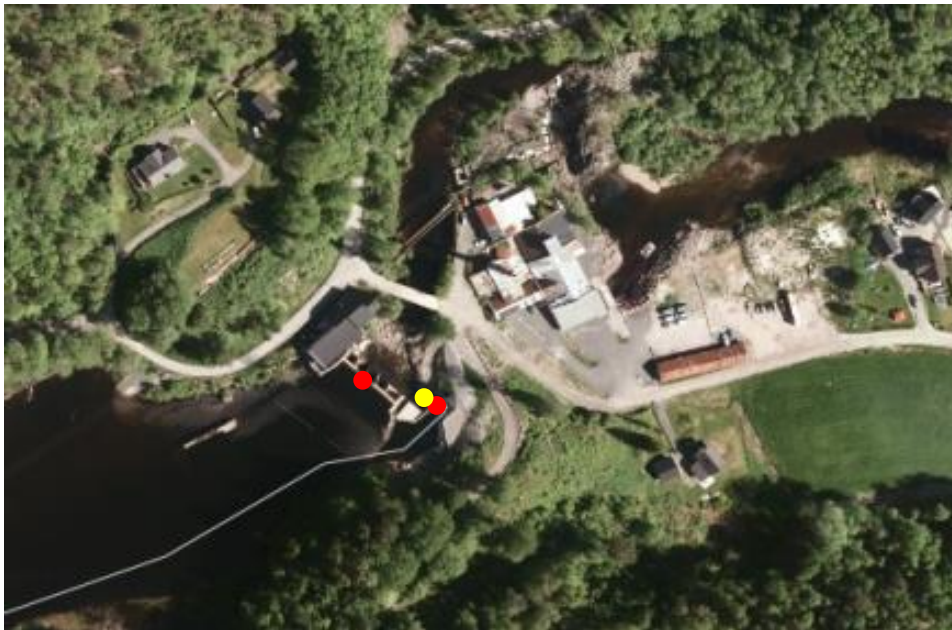
Figur 2. Flyfoto over Fosstveit kraftverk (kilde: Norge i bilder). Plassering av de to utvandingsrutene ål kan benytte uten tiltak er vist med røde prikker. Tiltaket er vist med gul prikk. Øverste røde prikk
