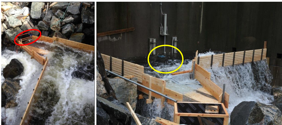
Figur 7. Fangstinnretning for ål ved Fosstveit kraftverk. Fangstkassa er innenfor rød sirkel i venstre bilde. Bunnluke kan skimtes under gul sirkel høyre bilde. Foto: F. Kroglund
