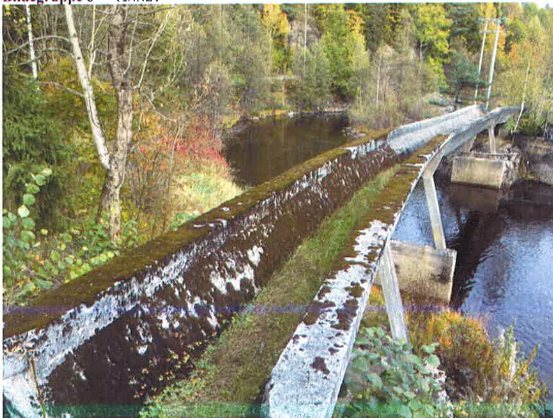
Bilde 6.1 Vannvei for gammelt kraftverk
