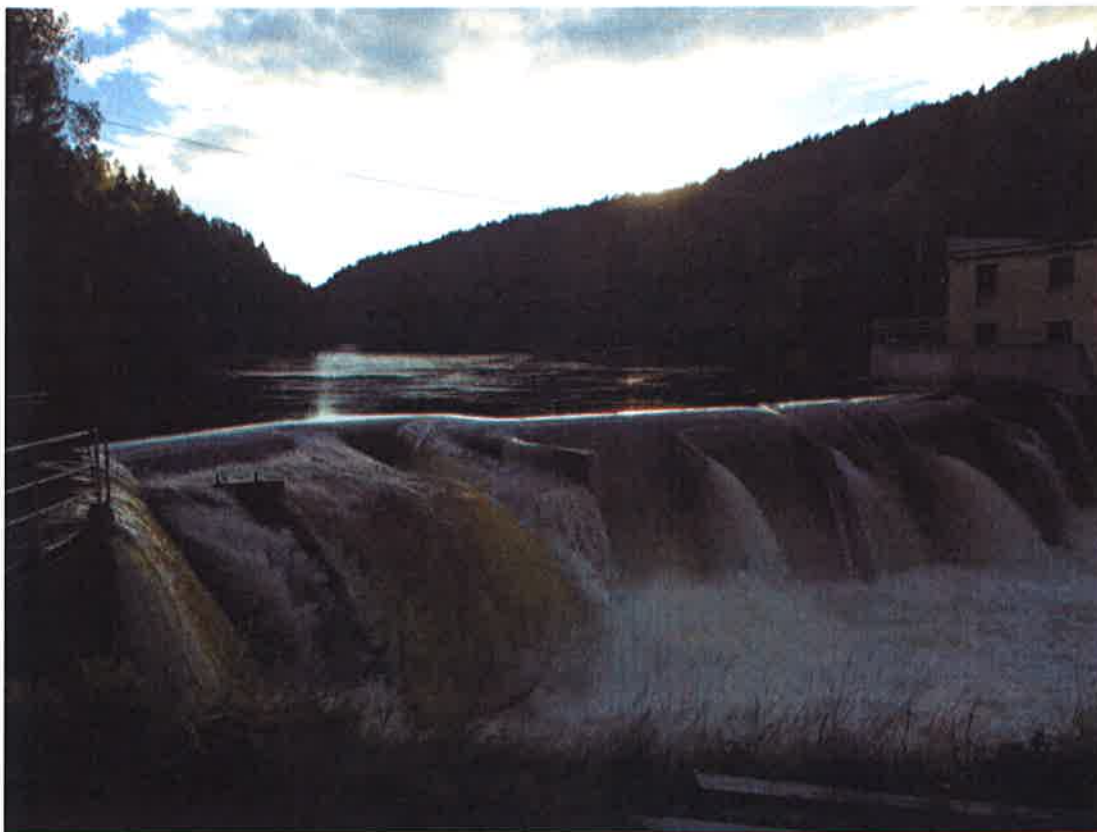
Bilde 1.1 Demning ved flom 2015-09-19
