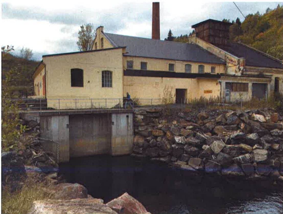
Bilde 4.2 Kraftstasjon avløp
