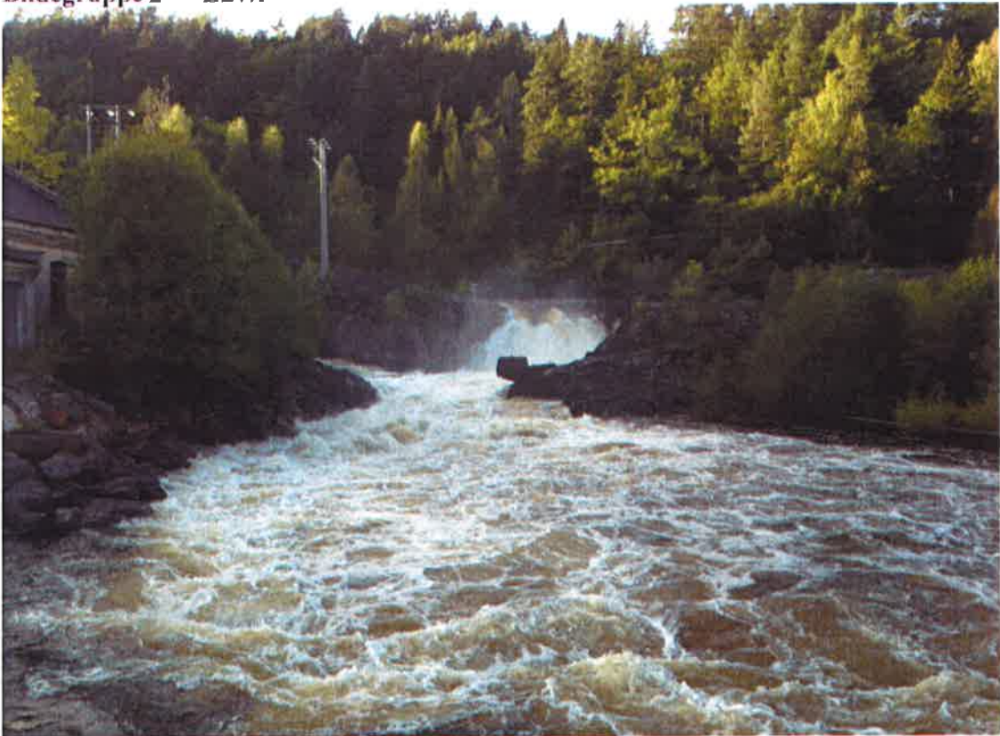
Bilde 2.1 Elv ned mot undervann ved flom 2015-09-19
