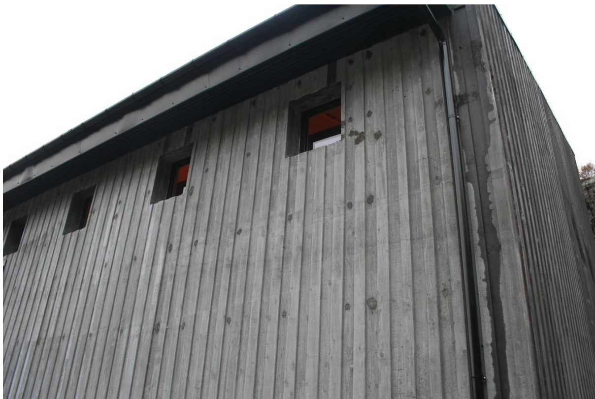
Figur 9: Illustrasjonsbilde. Ytterveggene på stasjonsbygningen planlegges støpt med forskaling av stående bord med innlagte lekter, så veggflatene får en struktur som minner om stående trepanel.
