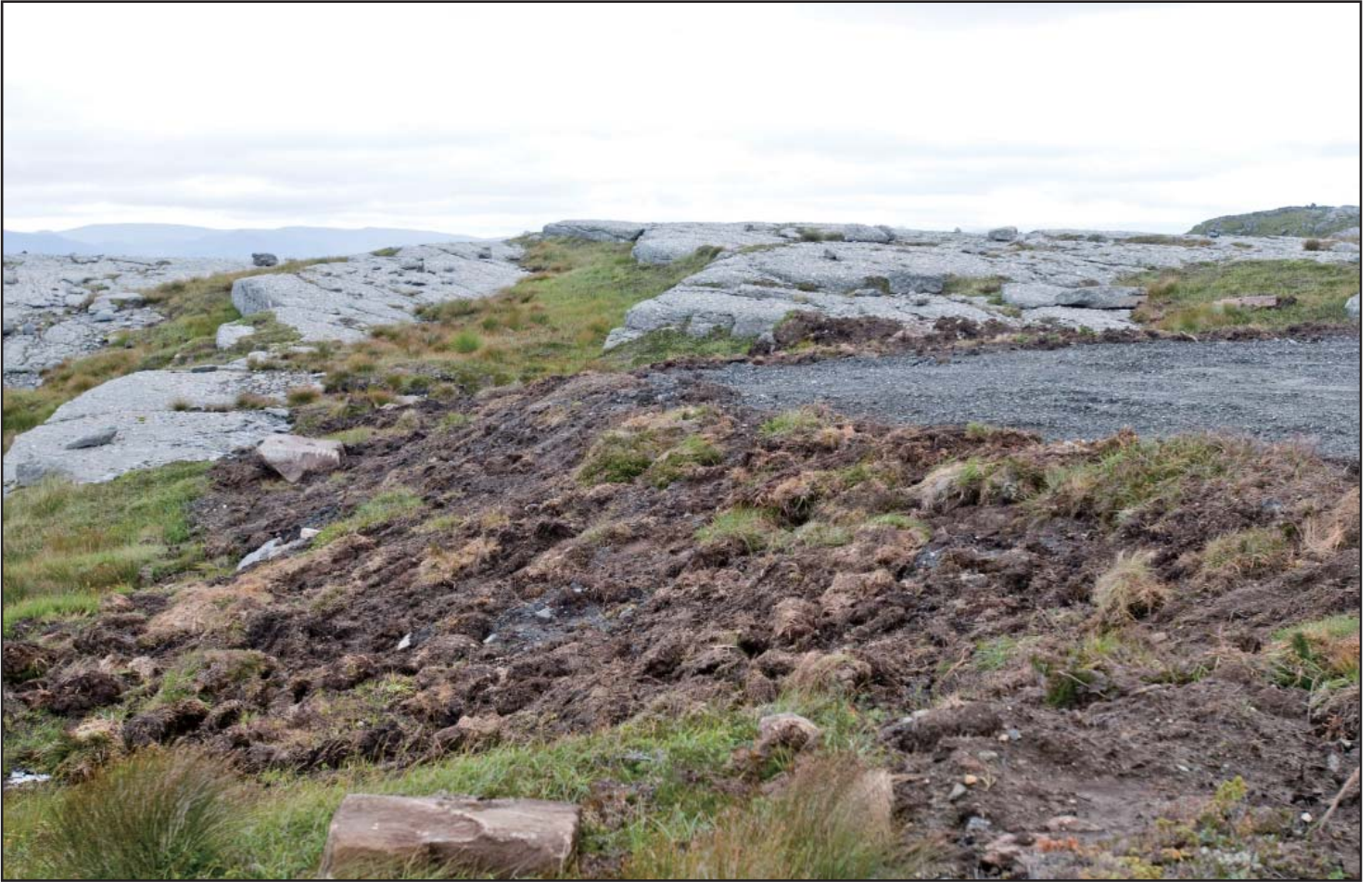
Nylig utlagt torv i kanten av en kranoppstillingsplass. Torva er ikke klappet til, og på sikt vil det gi raskest reetablering av vegetasjon.
