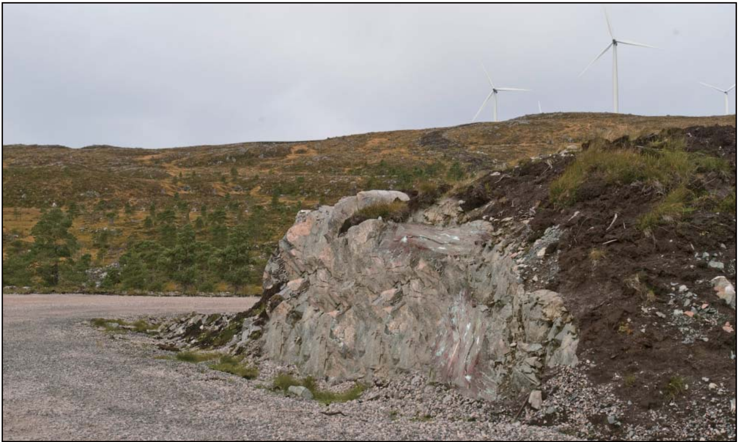
Fjellskjæring uten tiltak.
