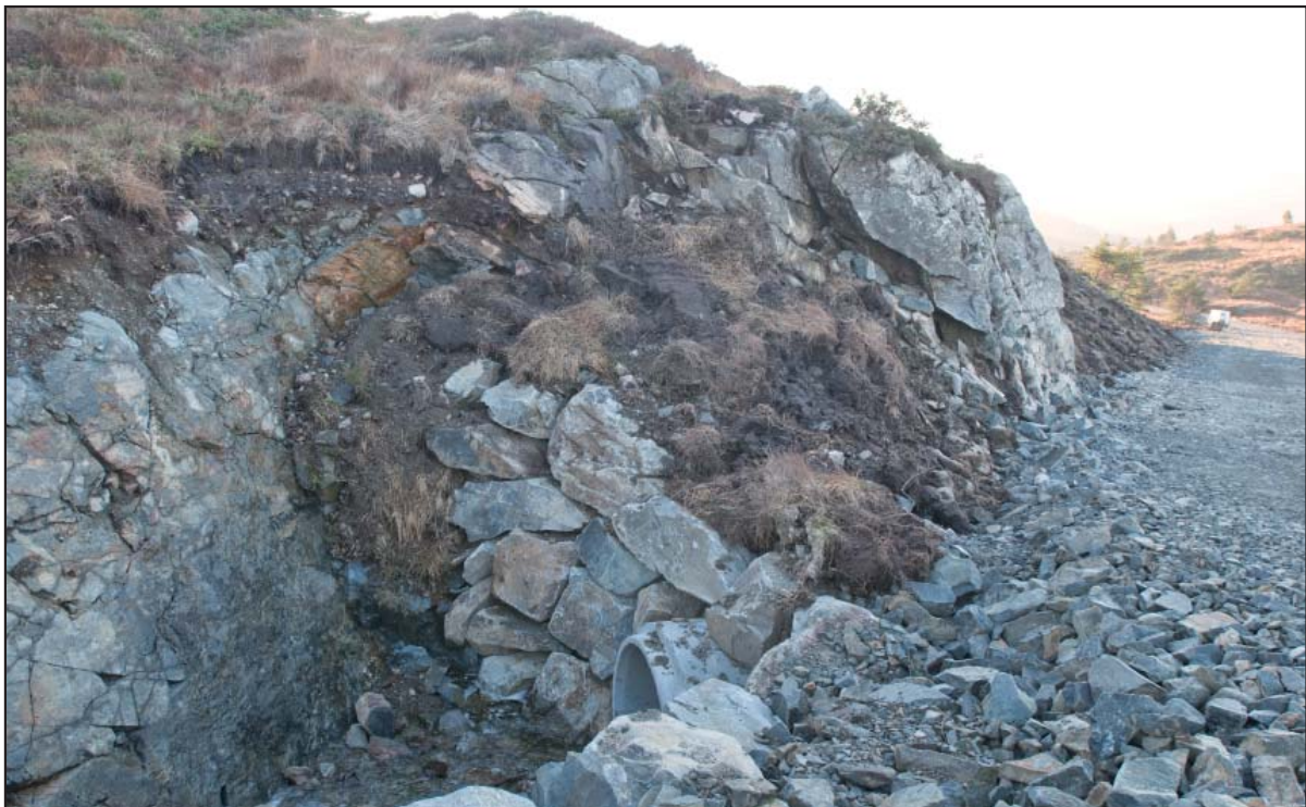
Eksempel på plastring med stein ved kulvert for framføring av vann under anleggsvei. Bildet er tatt i anleggsperioden, så terrenget rundt kulvert og vei er ikke ferdig arrondert.
