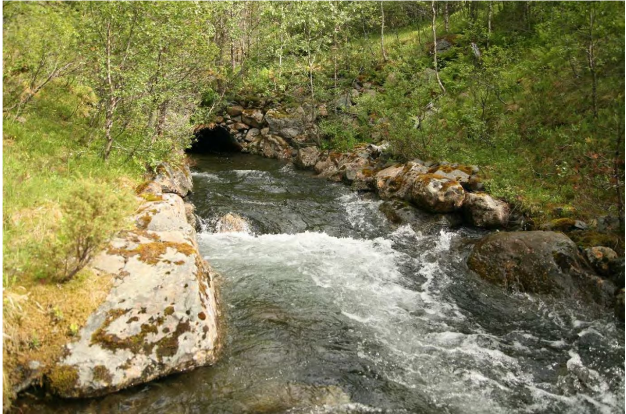
Figur 11 2013 06 28 Overføringskanal frå Langevatn mot Brandevatn.
