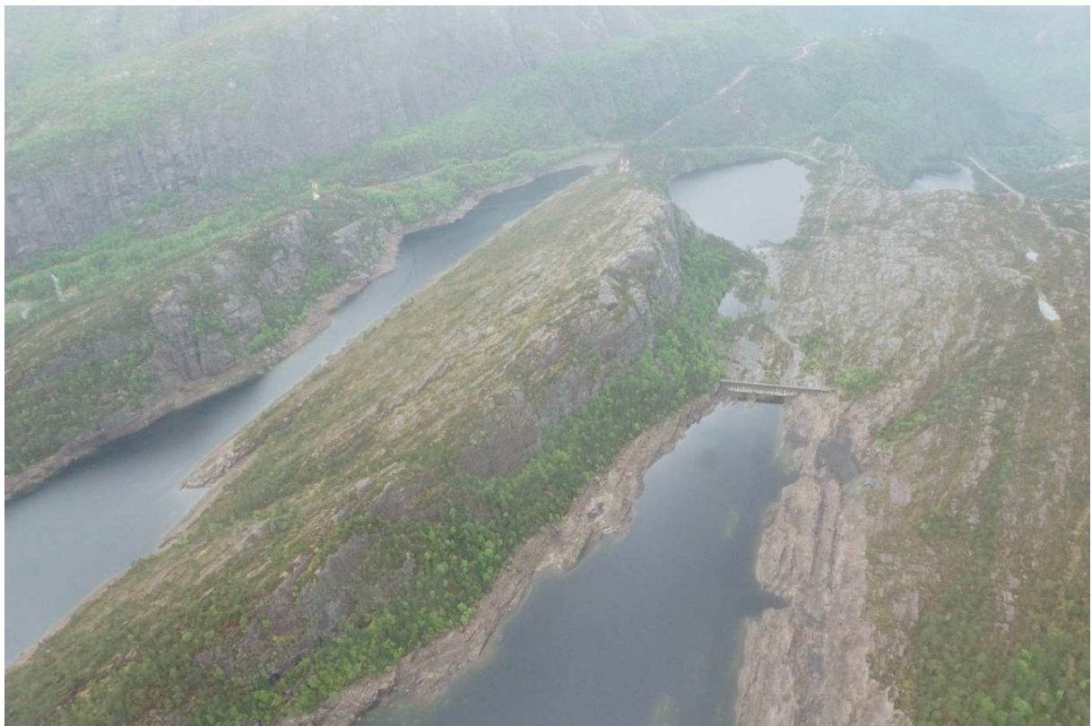
Figur 12 2013 06 07 Dam Svelgsvatn og vasstrengen vidare til Storefossvatnet og Lisjevatnet.
