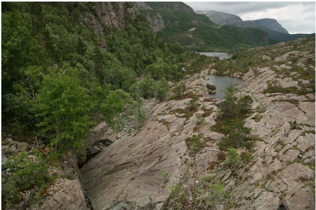
Figur 12 2013 06 28 Tørrlagt elveløp nedstrøms Svelgsvatnet sett frå dammen.
