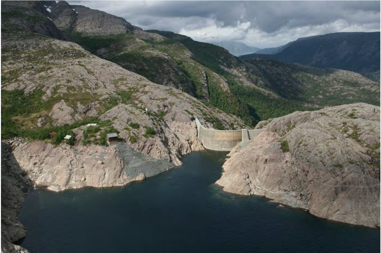
Figur 21 2013 06 07 Dam Hjelvevatn med lukehus, tipp, hytte, naust, helikopterlandingsplattform og ein transformatorstasjon som ikkje er i bruk.
