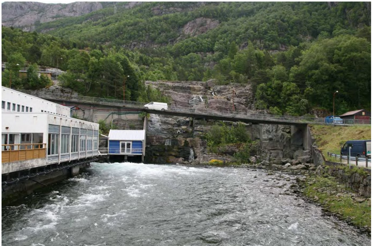
Figur 20 2013 06 28 Nedre del av Svelgsfossen og Fossekalen mikrokraftverk (blått bygg).
