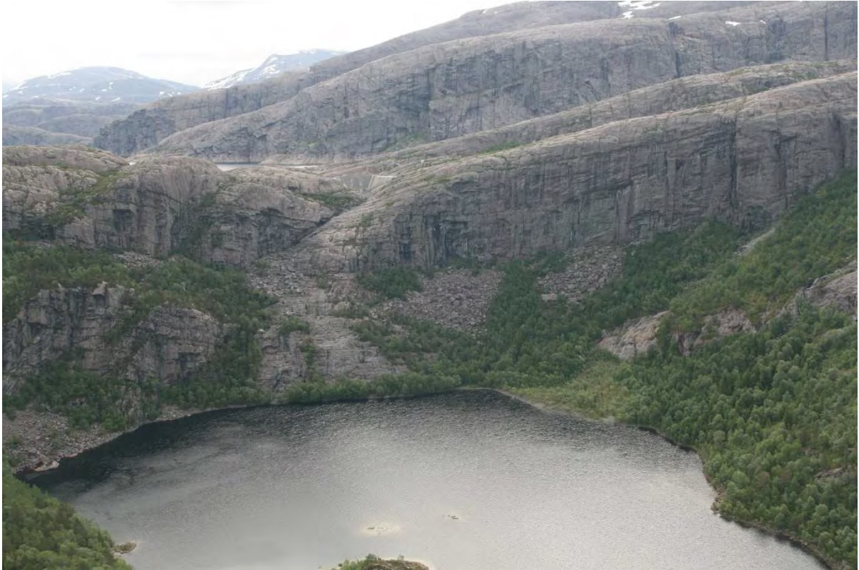
Figur 25 2013 06 028 Tørrlagd elvestrekning mellom Dam Hjelmevatn og Ivervatn.
