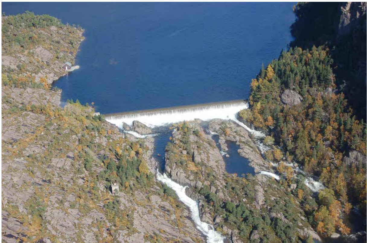
Figur 14 2007 09 17. Overløp over dam Svelgsvatn. Vassføring over dammen ca. 14,7 m 3 /s.
