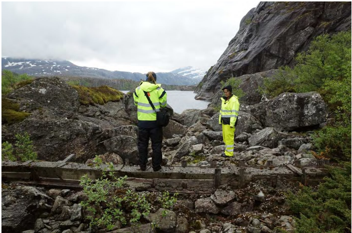
Figur 4 2013 06 07 Dam Nibbevatn nord.
