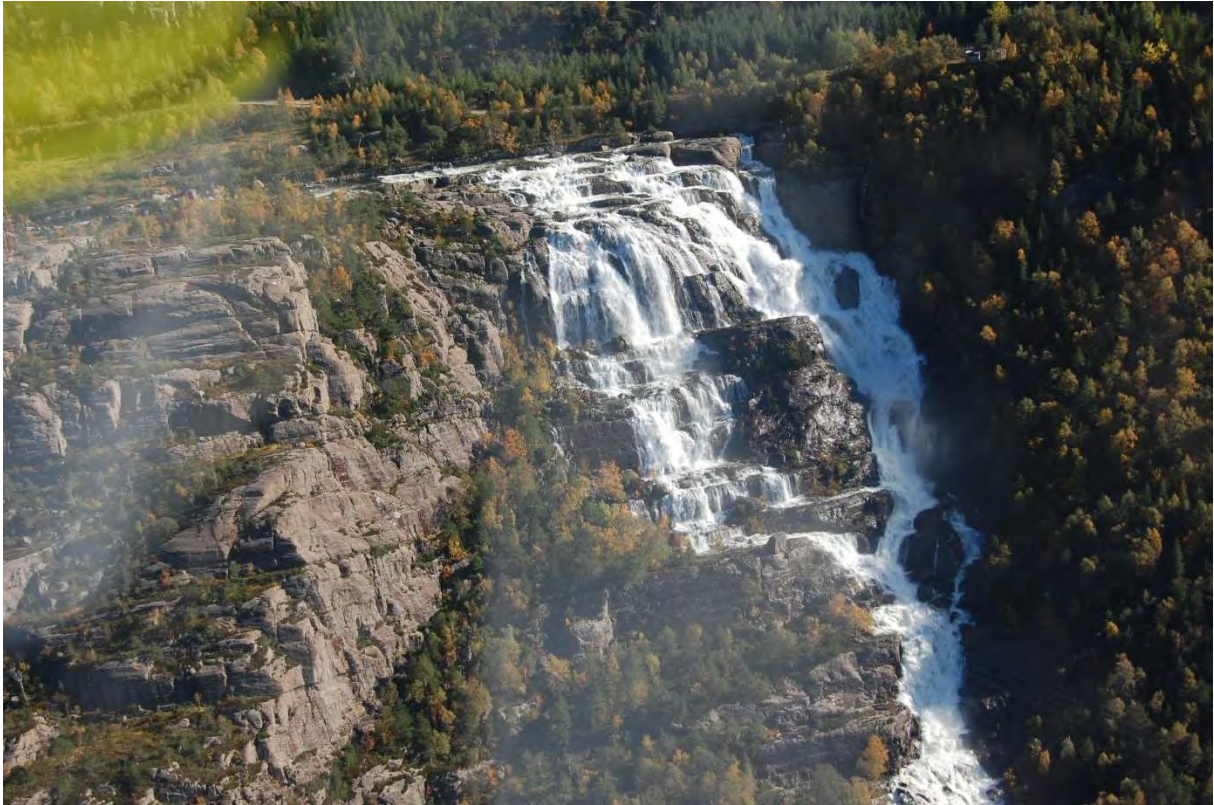
Figur 17 2007 09 17. Vassføring i Storefossen ved overløp på dam Svelgsvatn på ca. 14,7 m 3 /s.
