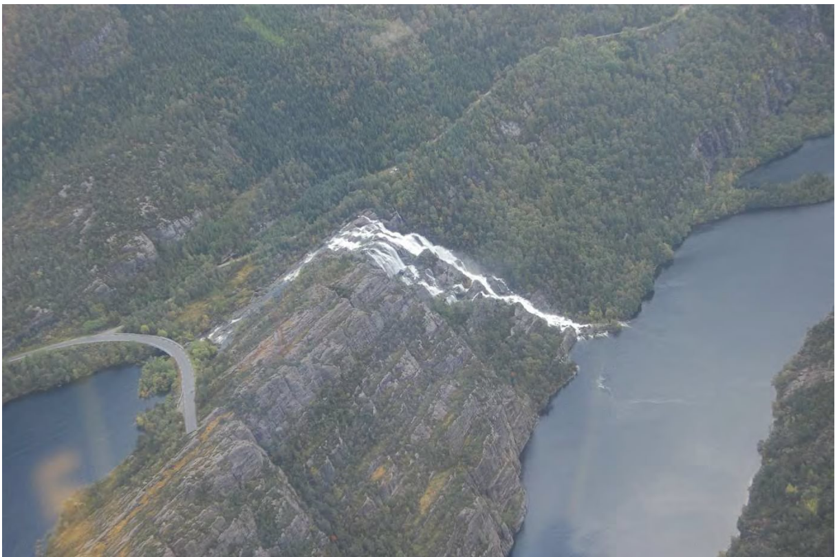
Figur 18 2007 09 17. Vassføring i Storefossen ved overløp på dam Svelgsvatn på ca. 14,7 m 3 /s.
