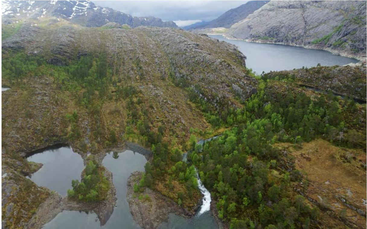
Figur 3 2013 06 07 Vingeavatn bak til høgre, Nibbevatn i framkant. Overføring frå Vingeavatn til Nibbevatn. Tunneltipp 8 Vingeavatn ligg inntil Nibbevatn.
