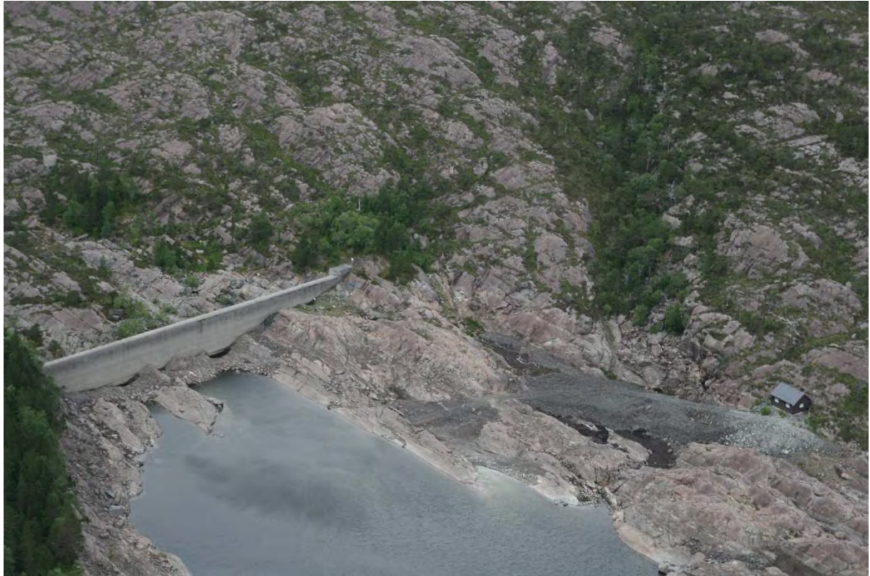
Figur 13 2013 06 28 Dam og tipp i Svelgsvatnet.
