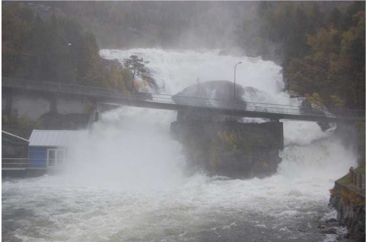
Figur 21 2007 09 25. Nedre del av Svelgsfossen og fossekallen mikrokraftverk ved overløp på dam Svelgsvatn på ca. 48,6 m 3 /s.
