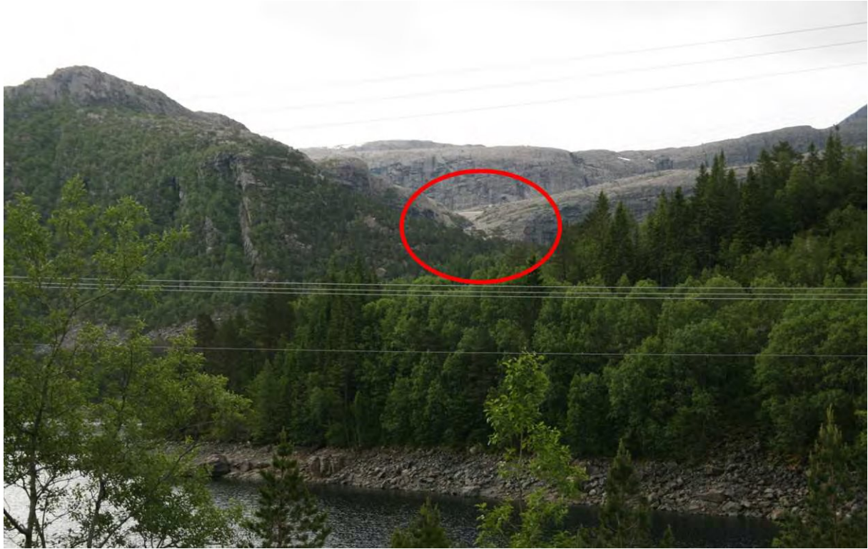
Figur 23 2013 06 28 Dam og transformatorstasjon ved Hjelmesetvatnet kan så vidt skimtast fra Fv614 (tatt med normal brennvidde).
