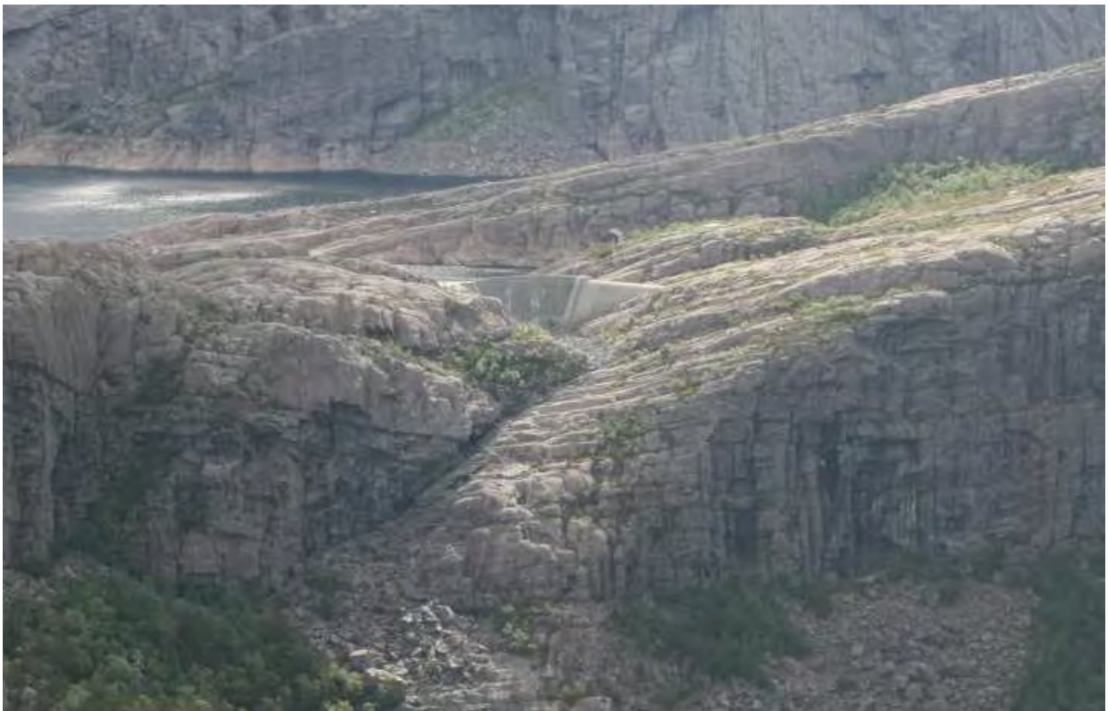
Figur 22 2013 06 28 Dam Hjelvevatn frå nedstraums side.
