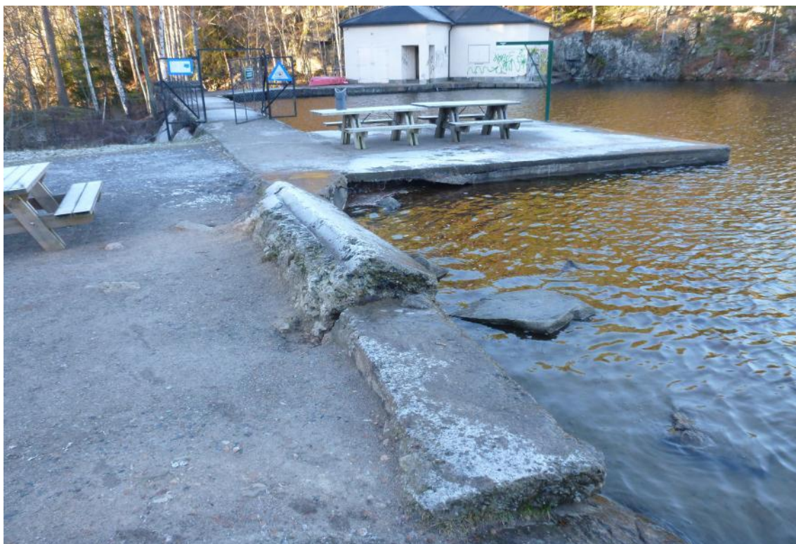
Bilde 4: Terskel ved venstre vederlag fjernes. Tettevegg i betong anlegges langs venstre kant av bilde og fylles ned på opp- og nedstrøms side. Betongbryggen rehabiliteres med ny vannfront.
