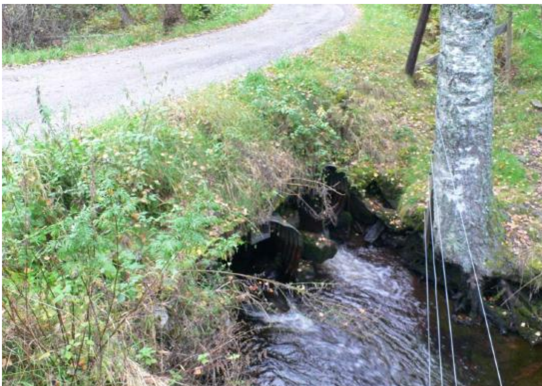
Figur 13: Eksempel på kulverter i vassdraget. (Kulvert under lokalvei ved Sagdam)
