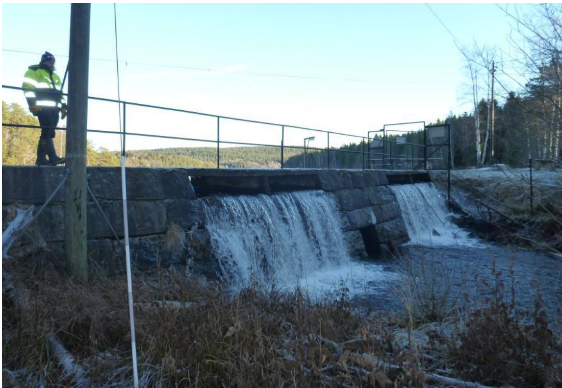
Bilde 2: Flomløpet ombygges til et fritt avtrappet overløp i betong. Overløpslengden økes til 17 m. Tappeluker i overløpet fjernes.
