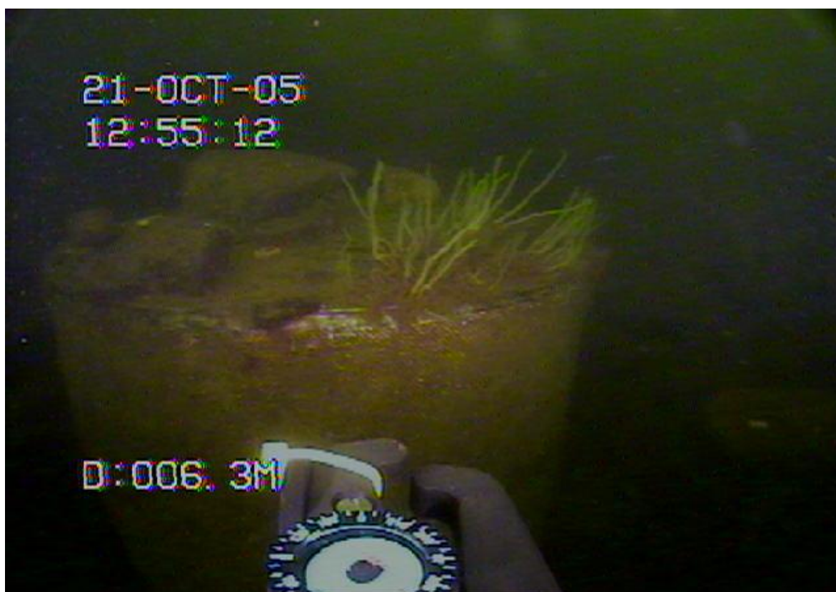
Bilde 5: Hulrom mellom frontale betongplate og bakenforliggende murdam ved høyre vederlag gjenstøpes
