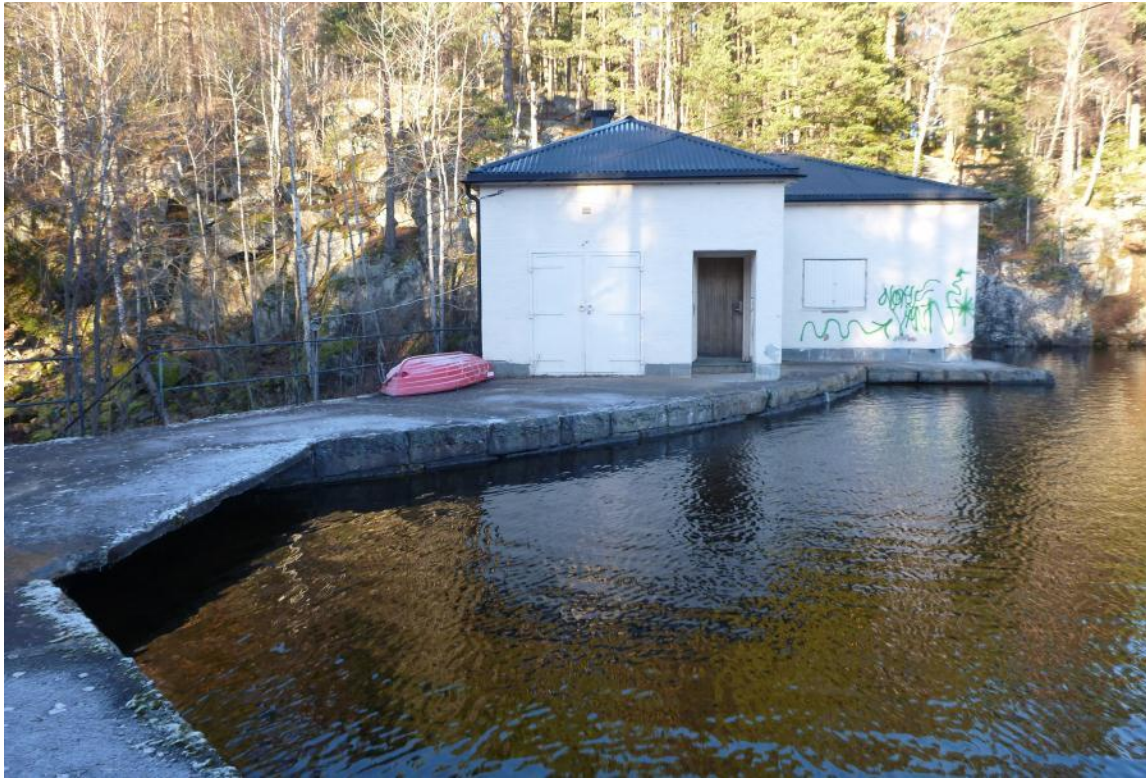
Bilde 1: Oppstrøms side påstøpes betongplate som forlenges 0,3 m over eksisterende damkrone. Øvrig damkrone påstøpes 0,1 m betongdekke.
