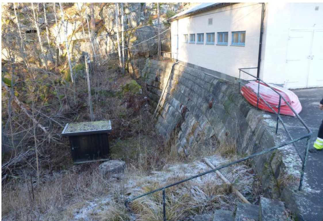
Bilde 3: Rørarrangement gjennom og nedstrøms dammen bygges om. Nedstrøms ventilhus erstattes av kummer.
