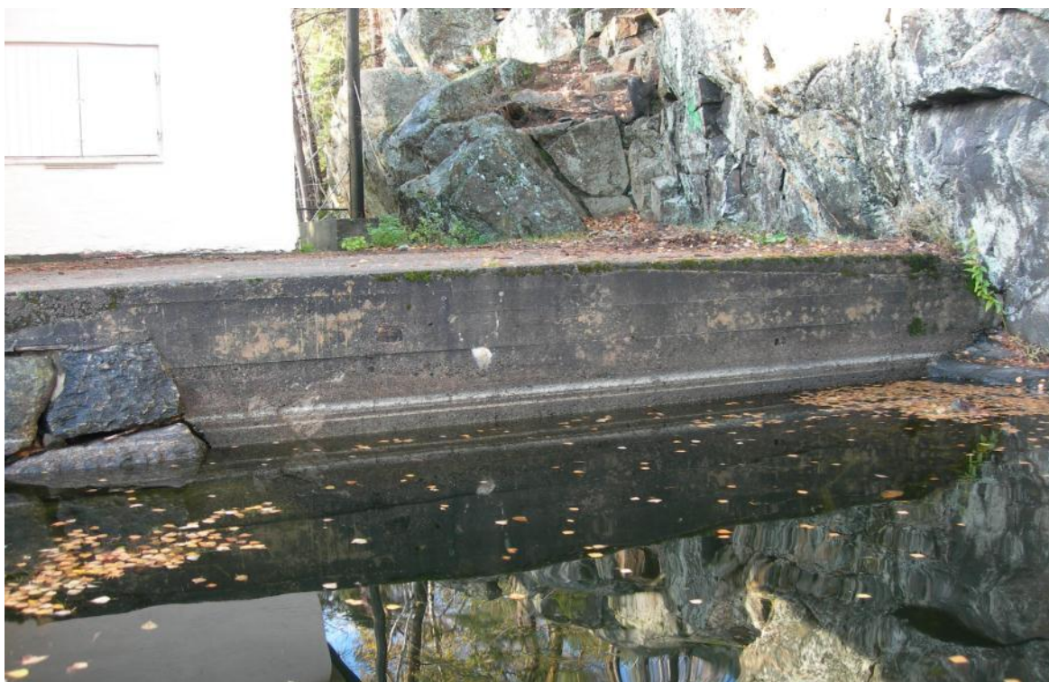
Bilde 5: Hulrom mellom frontale betongplate og bakenforliggende murdam ved høyre vederlag gjenstøpes
