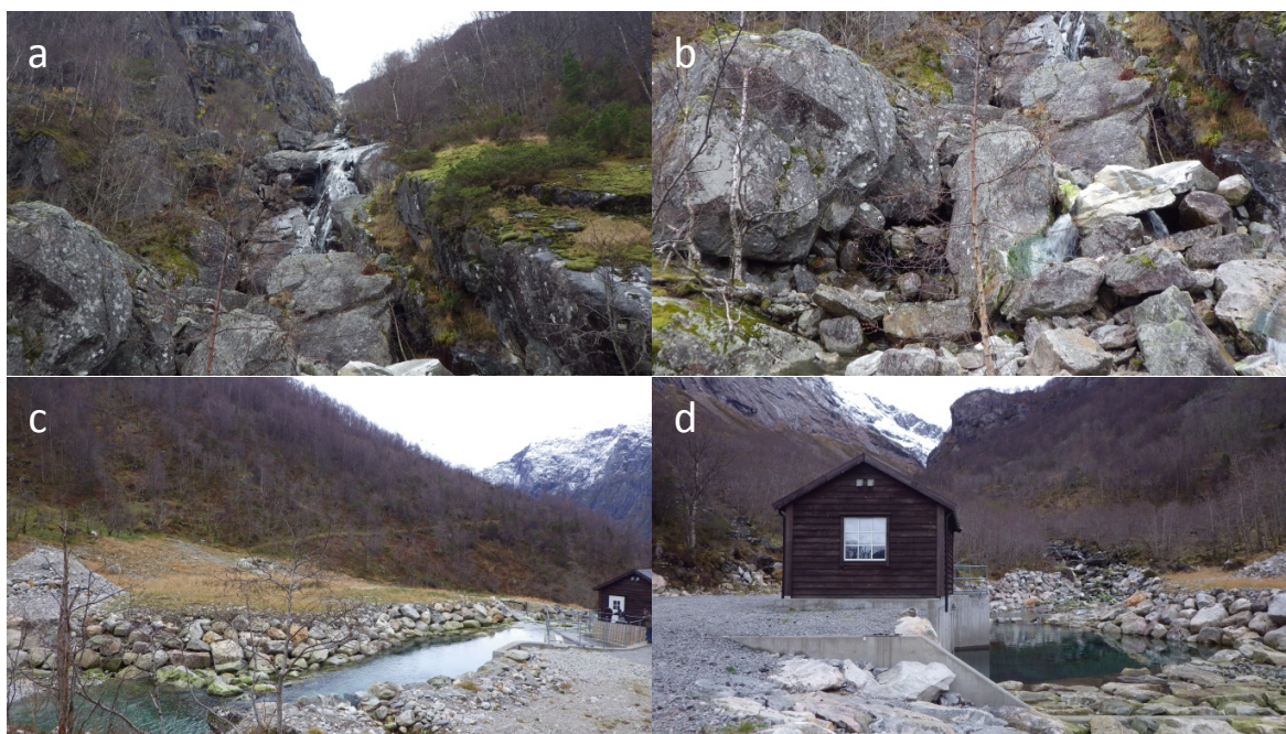
Figur 2.1. Utvalde bilete av tiltaksområdet, a) oppstrams inntak Reppaelva, b) inntak Reppaelva, c) sti/enkel veg som syner planlagd røytrase (sentrert og mot høgre i bilete) og d) utlaup for røytrase ved eksisterande inntak Tveitelva kraftverk.
