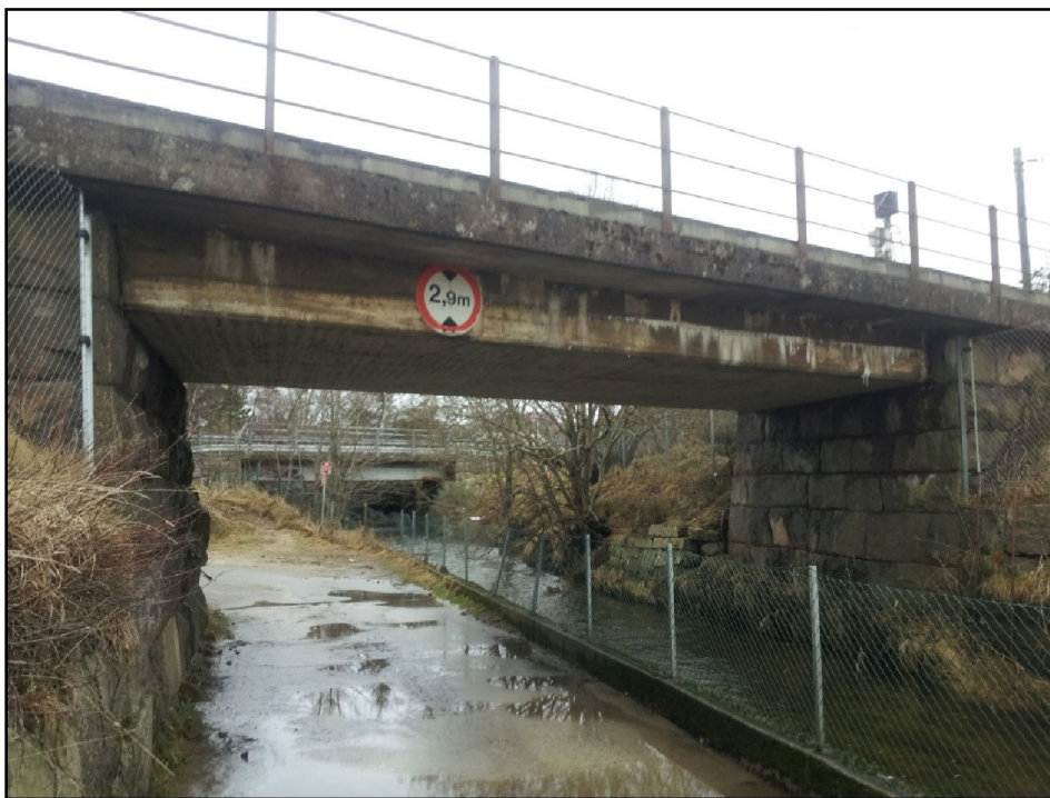
Figur 5. Helgåvassdraget under jernbanebru(nærmest) og Fv. 44 (i bakgrunnen).
