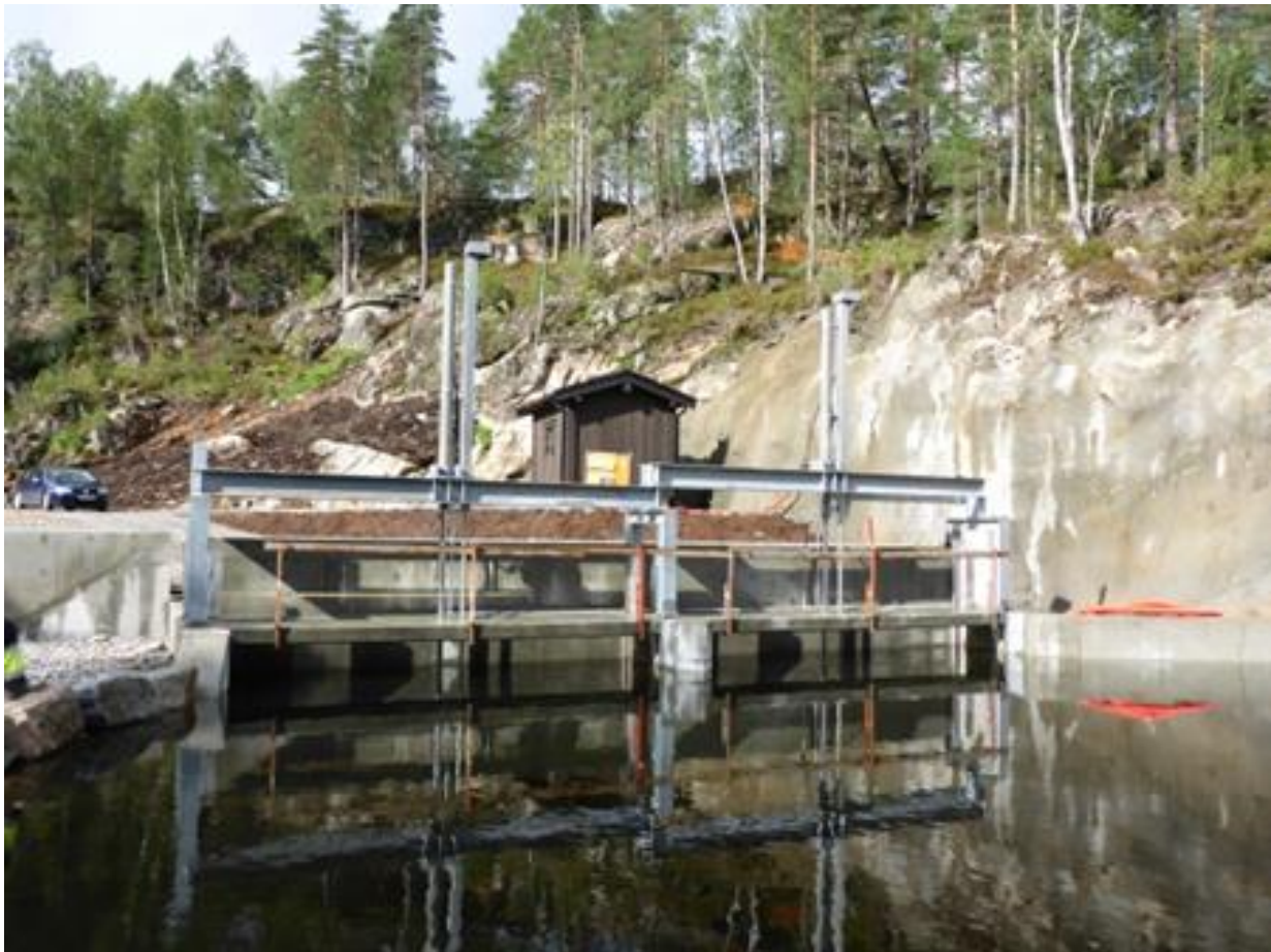
Figur 2.7 Eksempel på inntak, her fra inntaket til Skripelandsfossen Kraftverk.
