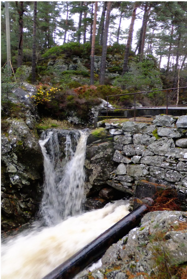
Bilde 2. Inntaksdam overløp, bunntappeluke og rørkonus Bildet er tatt 24. okt. 2014 med åpen bunntappeluke i flomsituasjon.
