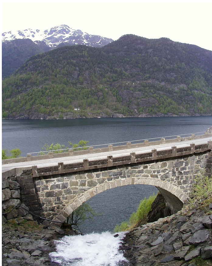
Skålnes Bru, den sist bygde kvelvingsbru i Hordaland. Foto: Erik Kvalheim.
