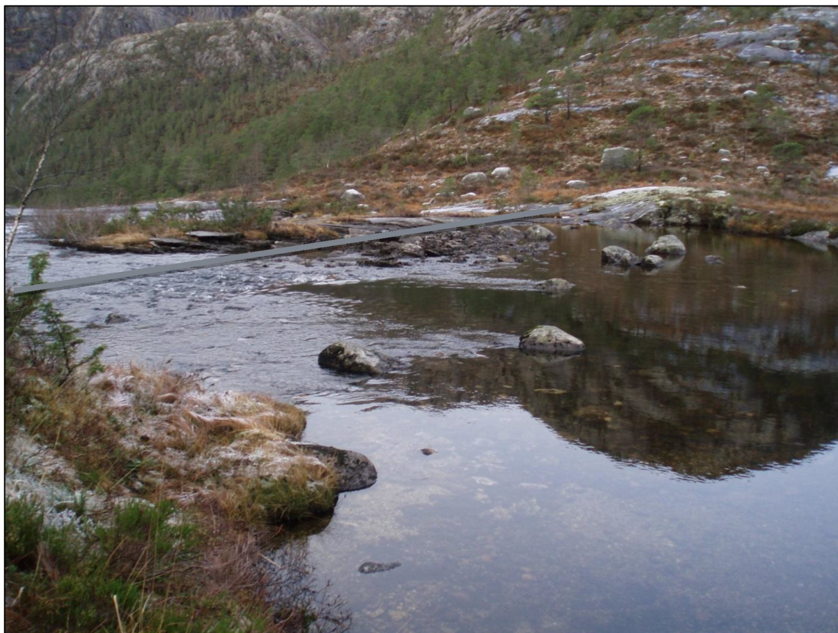
Fig. 7. Bildet viser området for inntak, med en terskel illustrert i bildet. Overløp følger hovedløpet, og inntakskonstruksjon kommer helt i venstre billedkant. Foto. Tiltakshaver.
