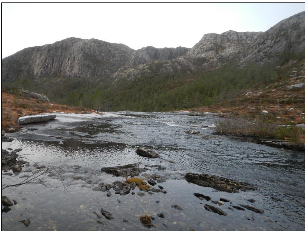
Inntak sett fra oppstrøms side
