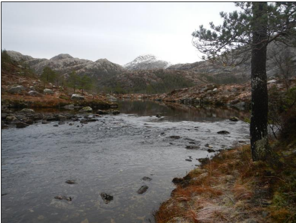
Område for terskel og inntak
