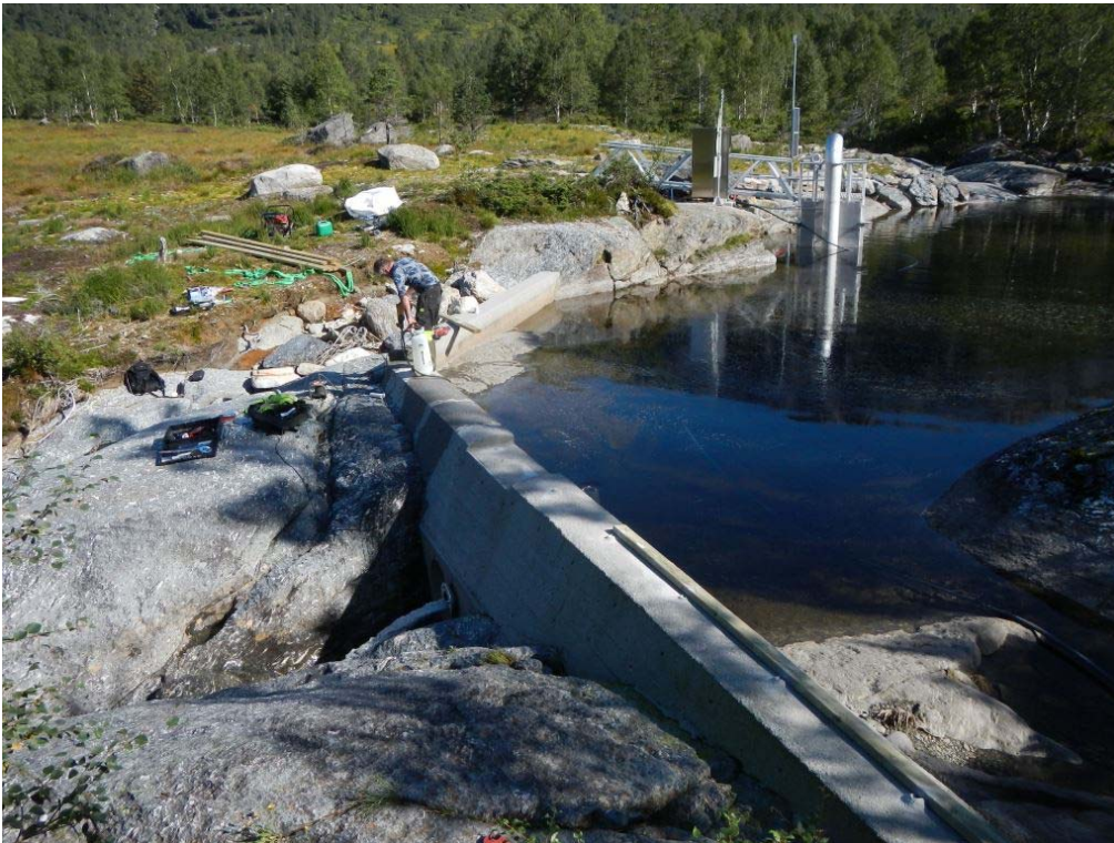
Figur 2.4A Eksempel på lav sperredam, Vågaåna i Vindafjord
