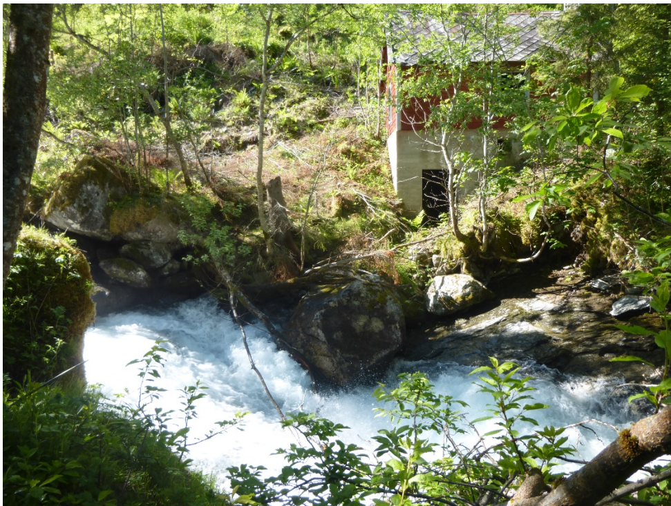
Fig. 3.8. Ved utløpet frå det gamle kraftverket.
