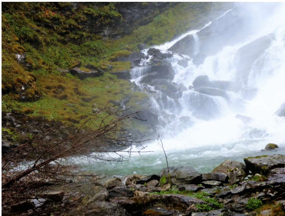
Fig 1. 2. 2 Bilde frå inntaksdammen ved stor vassføring. Bildet er teke mot autsida.
