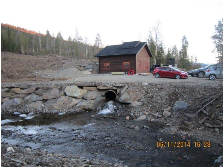
Halvdagsåa kraftverk ved elva.
