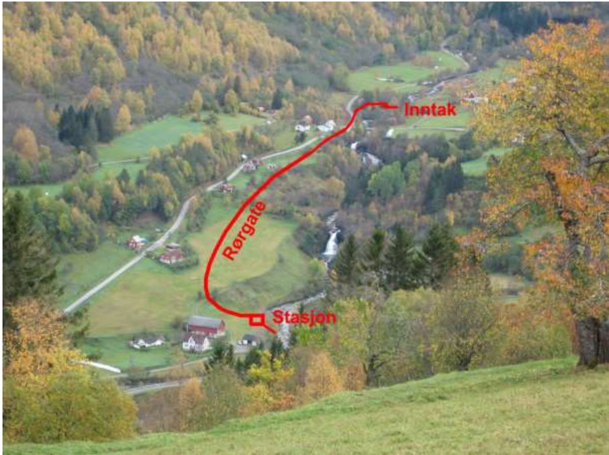
Figur 1.4.1 Engeset - Dalhus oversiktsbilete, med teikna inn inntak og stasjonsplassering.
