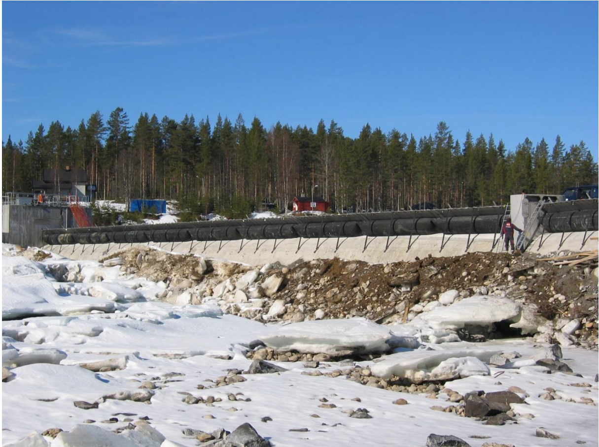
Bilde 2 Obermaier luker under installasjon i Sangfossen. Foto: Multiconsult.
