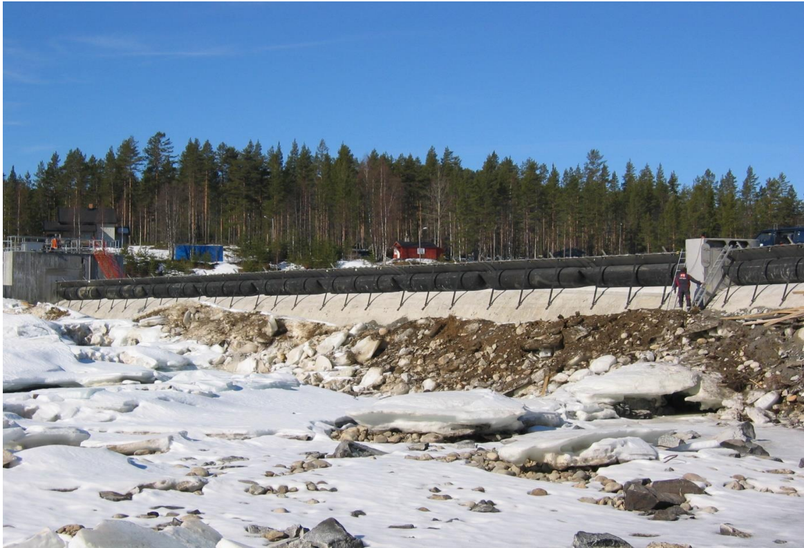
Bilde 2 Obermaier luker under installasjon i Sangfossen. Foto: Multiconsult.
