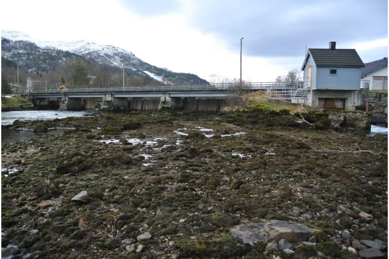
Bilde 1 Gammal nåledam i tilknytting til bru over Jølstra. Bilde er tatt 17.12.2012. Sørlig løp heilt til venstre blir nytta til fiskevandring. Foto: Sunnfjord Energi.
