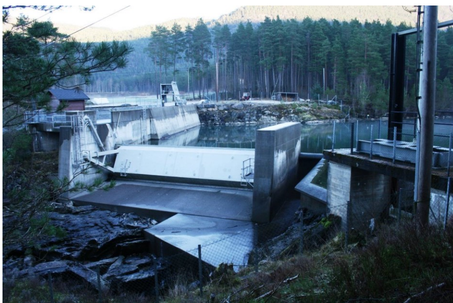
Dam og inntak i Eidsfossen. Tappeluka fremst i bildet skal nyttast til slepping av minstevassføring.
