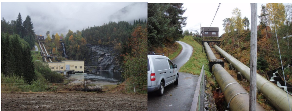
Eidsfossen kraftverk. Bildet til høyre: Røret til høyre med diameter 1,5-1,6 m skal skiftast ut med eit nytt rør med diameter 2,0 m.
