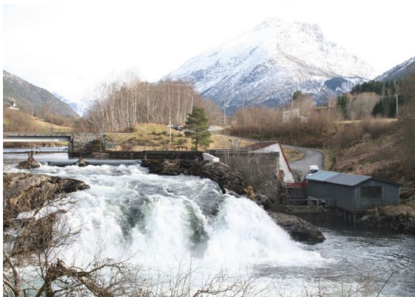
Enevøfoss kraftverk i dag. Klekkeriet til høgre.
