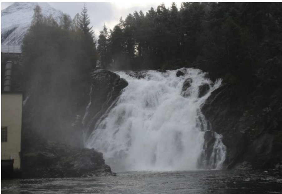
Eidsfossen med vassføring 8 m 3 /sek, tilsv. foreslått minstevassføring om sommaren.
