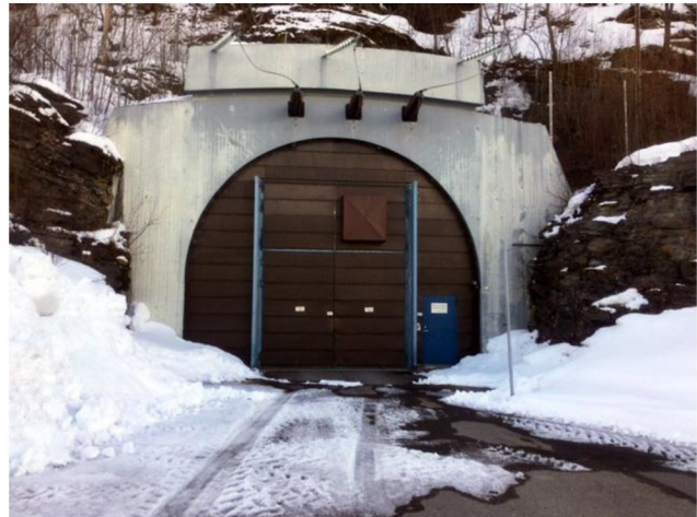
Bilde 2-1: Portalen til Guolas kraftverk
