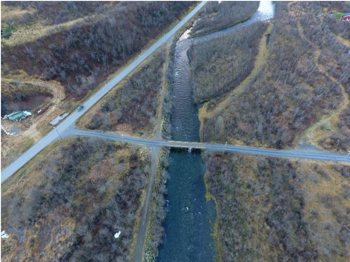
Bilde 2-8: Relativt typisk elveprofil, resultat av forbygninger. Her fra Nedre Holm bru. Vannføring 10 m 3 /s.
