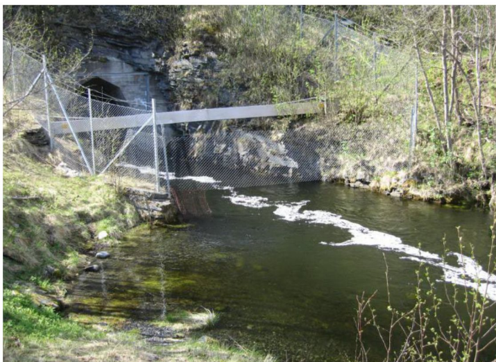
Bilde 6-6: Til venstre. Utløpet av avløpstunnelen. Inngjerding sees. «Bjelken» på tvers av kanalen er en kabelkulvert. Galgen kan så vidt sees i bakgrunnen.
