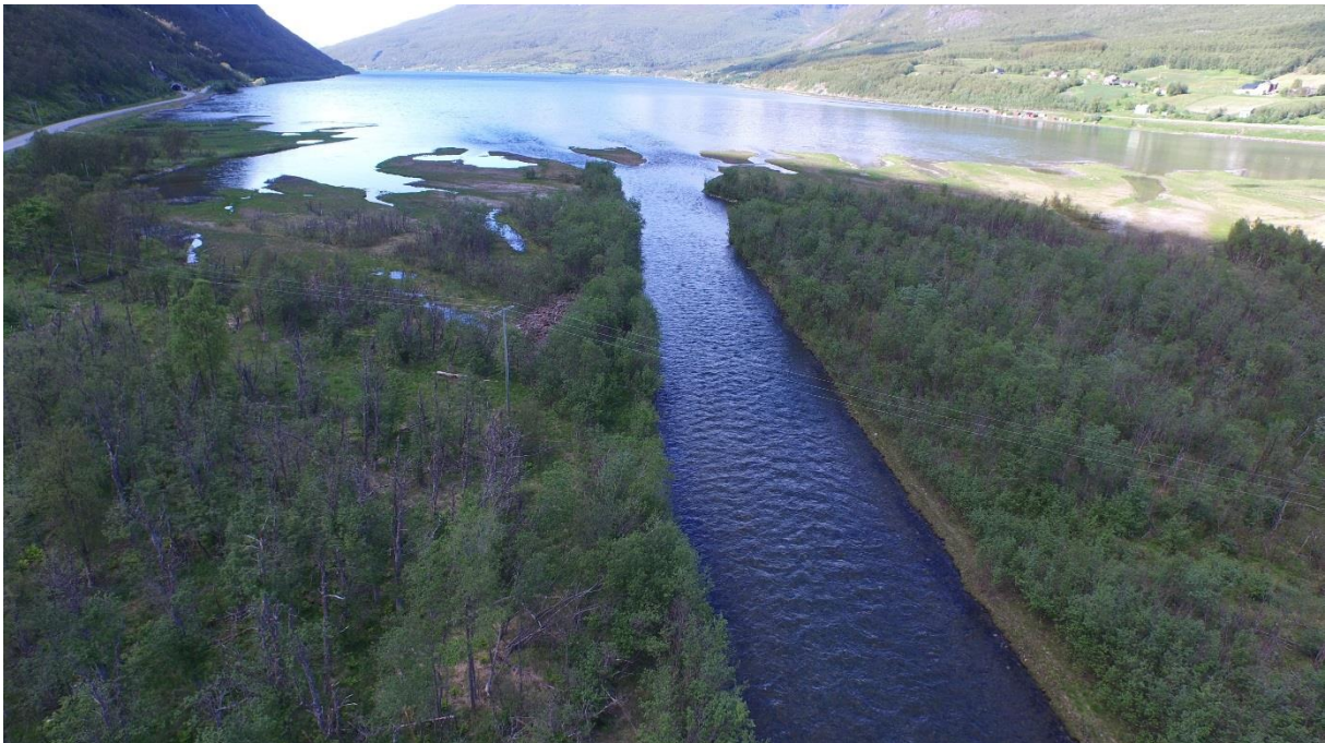
Bilde 6-1: Samling av utløpet av Kåfjordelva, biotopiltak utført etter skjønnspålegg i 1982. Vannføring 18,4 m 3 /s.
