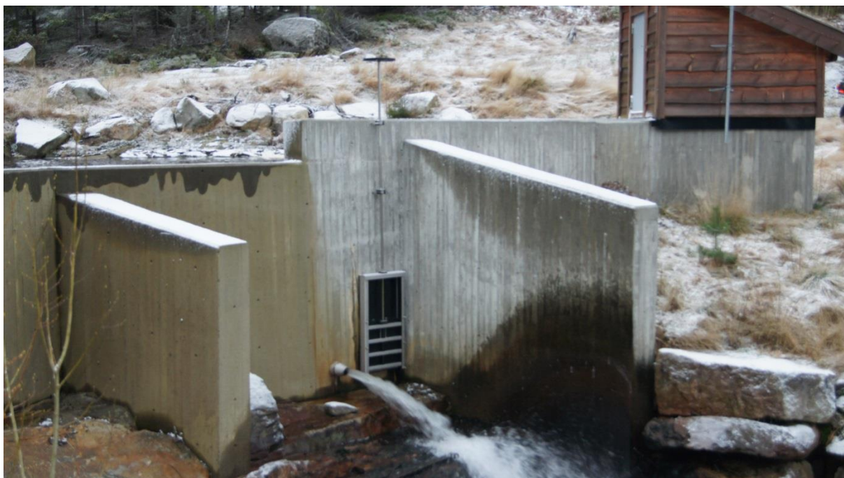
Fig 23. Inntak med slipp av minstevannsføring og tappeluke.
