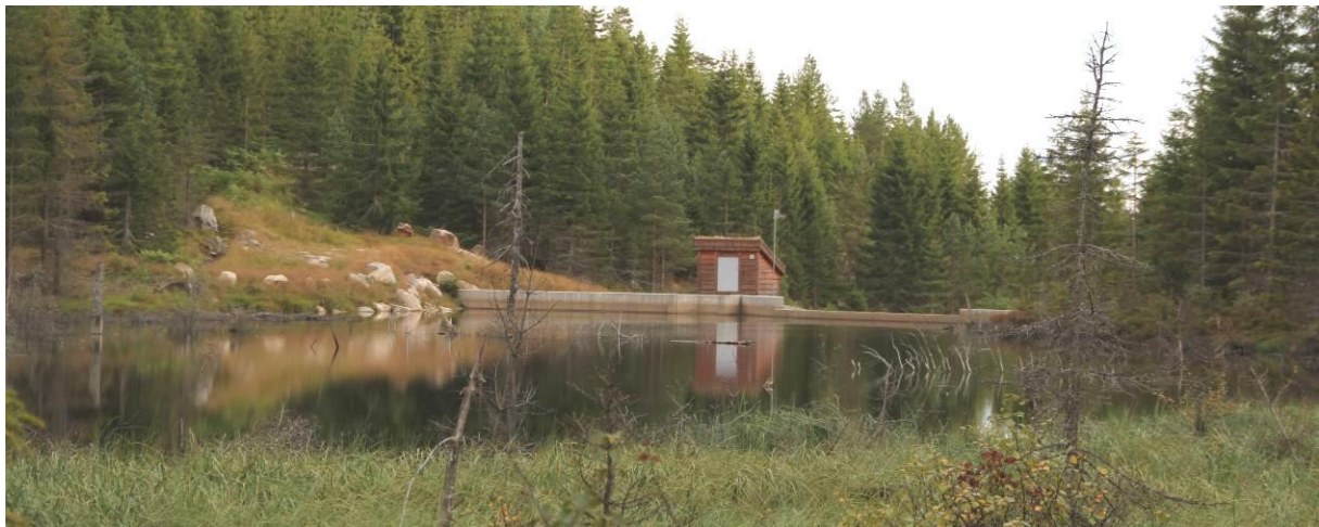
Fig 19. Vannspeil i inntak.
