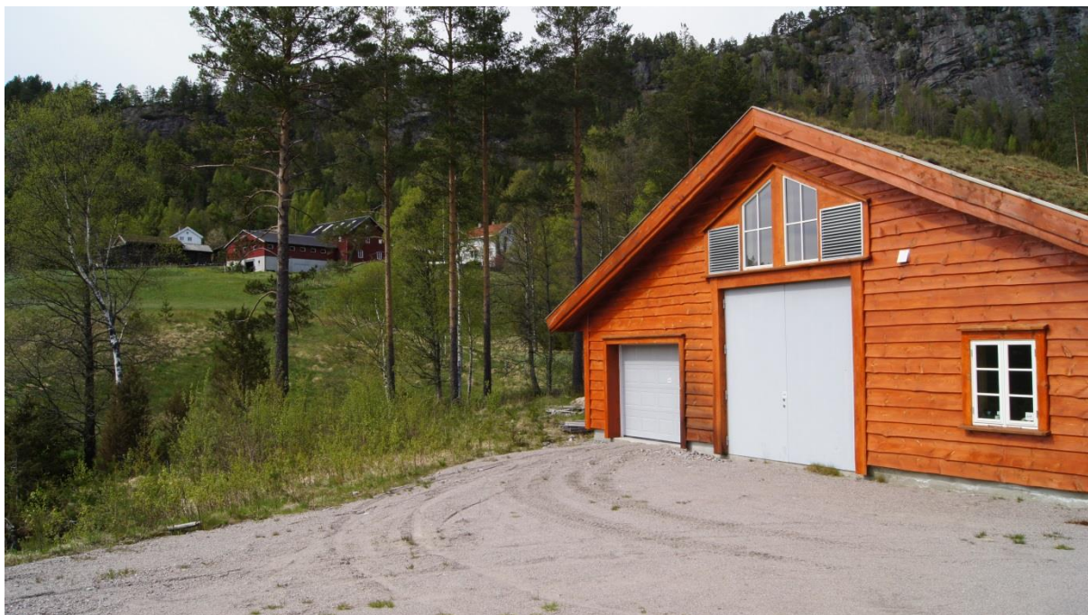
Fig 7. Harstveitbekken kraftverk med gårdene i bakgrunnen.
