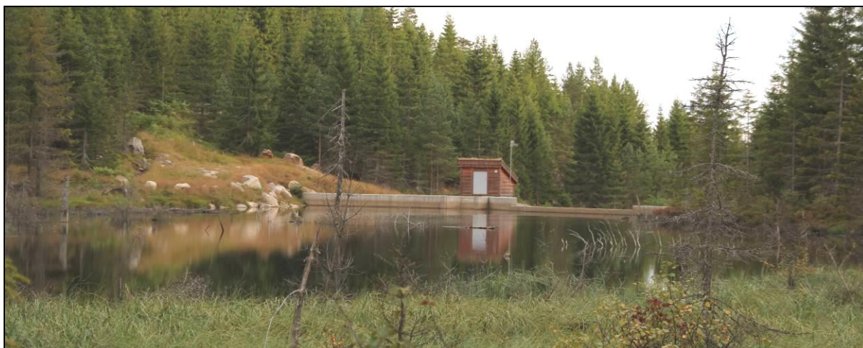
Figur 28. Alternativ 2: Inntaksmagasinet for Harstveitbekken kraftverk på Vylane, fotografert i 2013.
