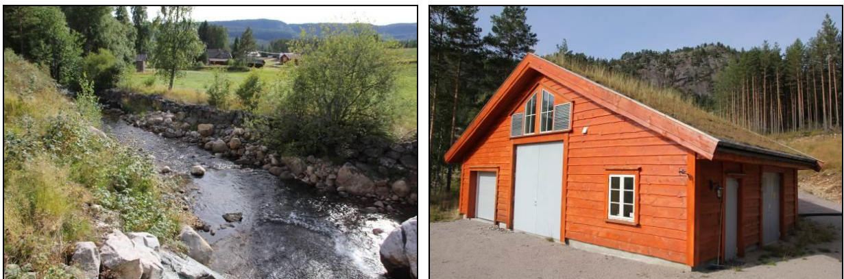
Figur 7. Eksisterende Harstveitbekken kraftstasjon, kote 215 (t.h.), og Harstveitbekken ved utløpet fra kraftstasjonen (t.v.). Overføring av Skrebekk vil øke vannføringen inntil 0,35 \text{ m}^3/\text{s} på en ca. 210 m lang strekning nedstrøms kraftverket.
