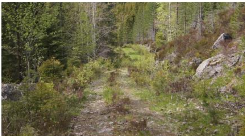
Vei med rørtrase for overføring.
