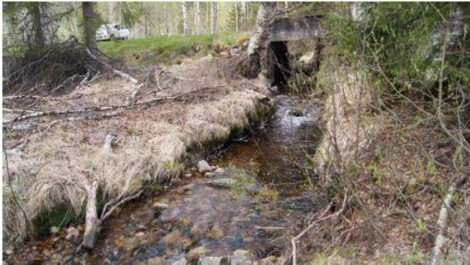
Skrebeekken like ovenfor sammløp med Harstveitbekken, ca 70 l/s vannføring.
