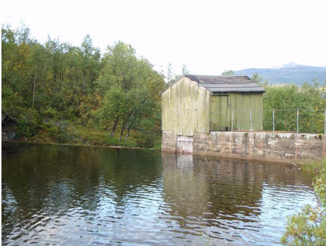
Eksisterende dam (kote 132 ) i tilknytning til gamle Foldvik lysverk.
