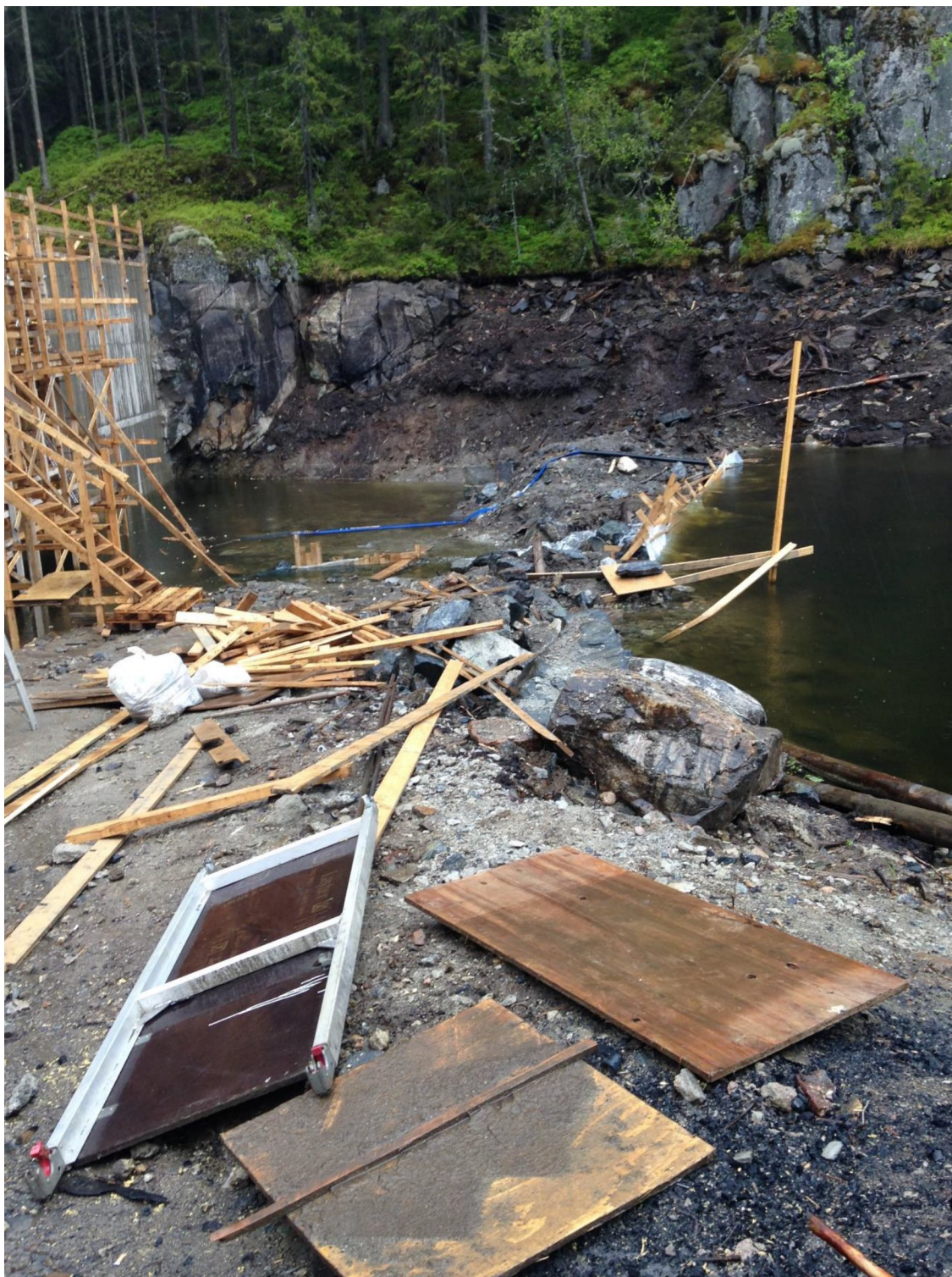
Figur 3 Dretvann. Bak demningen.
