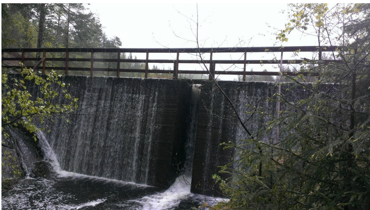
Figur 7 Demning ved Morterudvannet
