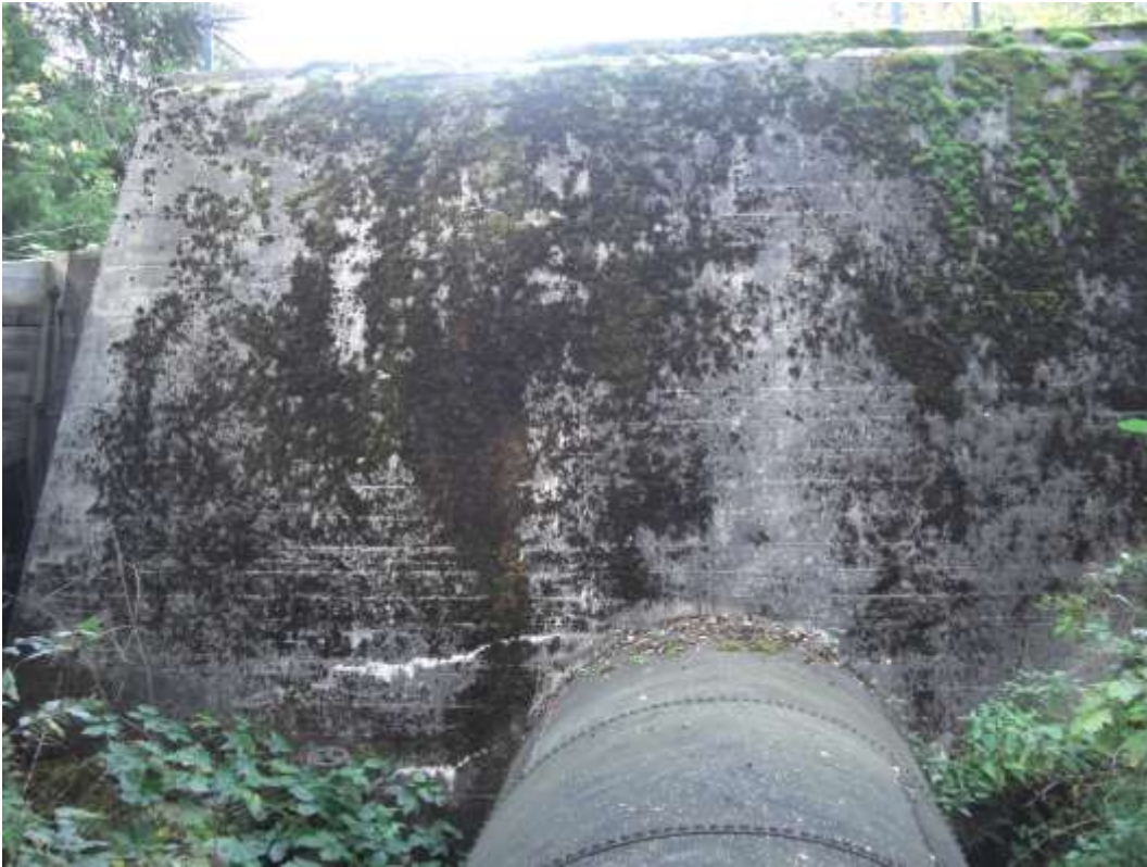
Bilde 8: Dagens rørgate ut av inntak. Foto: Rolf Amundsen
