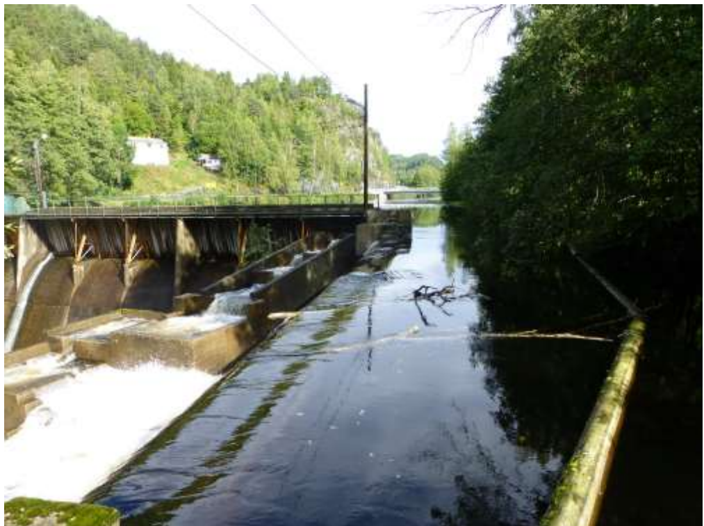
Bilde 3: Bildet viser dam og inntak, slik det fremstår i dag. Foto: Rolf Svan Amundsen.
