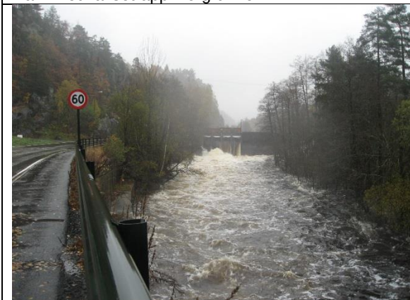
Øvre del av elva mot dammen i bakgrunnen.
