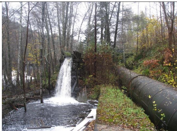
Tømmerrenne nedstrøms dam. Rørledning til høyre.
