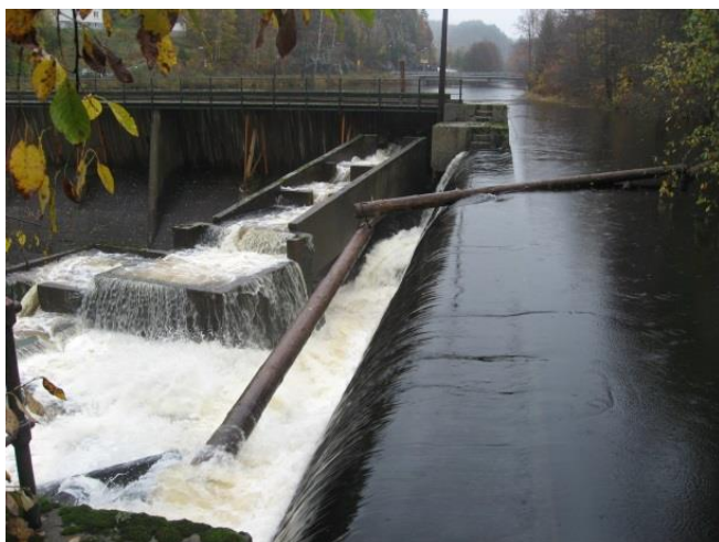
Figur 10. Laksetrappa med dammen i bakgrunnen på stor vannføring 23.10.2014. Foto: Sweco Norge.
