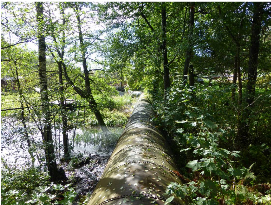
Bilde 10: Gammel rørgate sett nedover fra omtrent der utløpet fra skruer vil ligge. Foto: Rolf Amundsen
