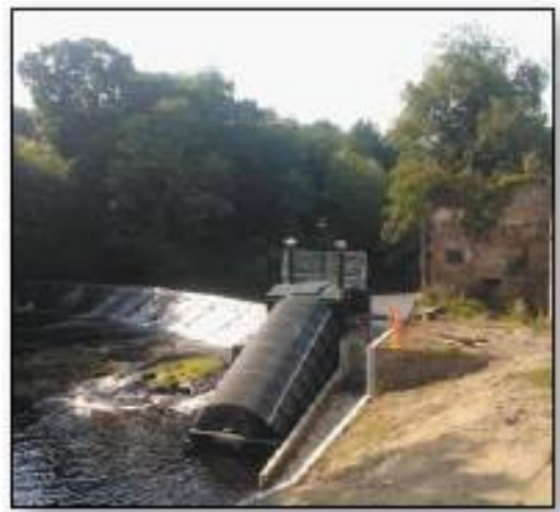
Bilde 7: Skrueturbin – Arkimedes skruer.
